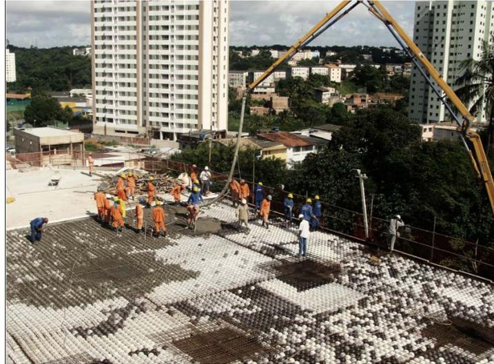
**Figura 1 - Construção da sede da Empresa Odebrecht no Brasil, com lajes tipo BubbleDeck (BubbleDeck Brasil, 2014)**
