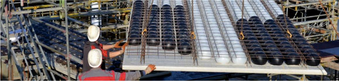
Figura 6 - Exemplo de laje *BubbleDeck* com pré-laje (*Bubbledeck Brasil*, 2014)
