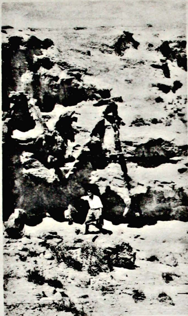
1. Grietas rellenas secundariamente con material arenoso fino y calcáreo, muy compacto, en el flanco austral del Cerro Lotena. Vista hacia el sud.
