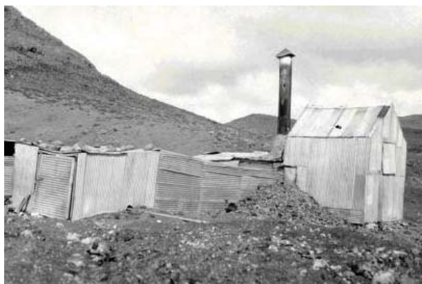
Figura 95. Planta de la fundición de mineral plumbífero del Agrupamiento Huayelón. Producción máxima: 2 toneladas en lingotes, en 24 horas (Fot. Ing. P. Sgrosso, fines de 1932, suministrada por el Archivo Histórico Visual, SEGEMAR, IGRM).
