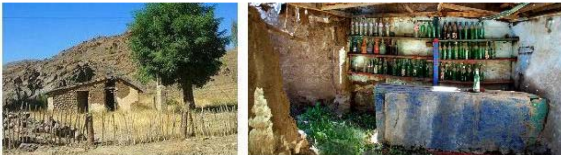
Figura 2. Bar minero en Huaraco. Ubicado sobre la ruta provincial 39, es una antigua construcción de adobe, piedra y techo de cartón, que funcionaba como bar y lugar de encuentro y festejo de los antiguos mineros.
