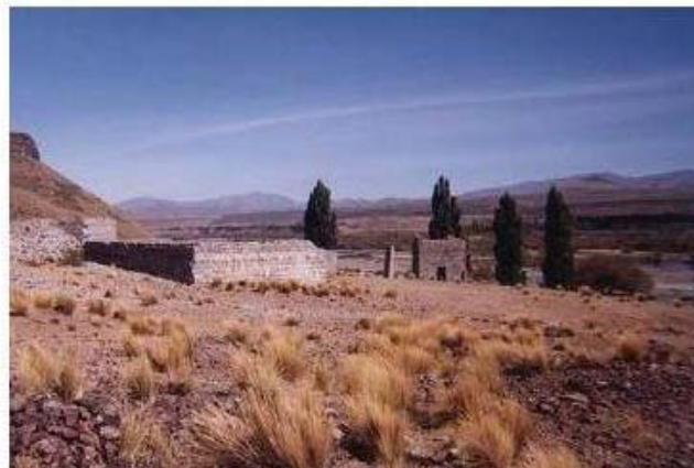
Figura 91. Ruinas de la planta de tratamiento del mineral del Agrupamiento Campana Mahuida.
