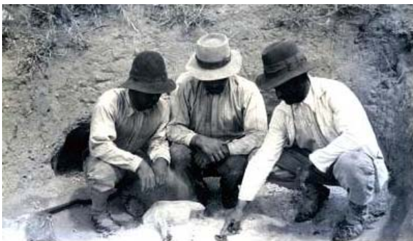
Figura 4. Mineros quemando amalgama de oro en cerro Mayal, Chos Malal. Fot. Ing. C. Bravo, diciembre de 1933, Archivo Histórico Visual, SEGEMAR, IGRM.
