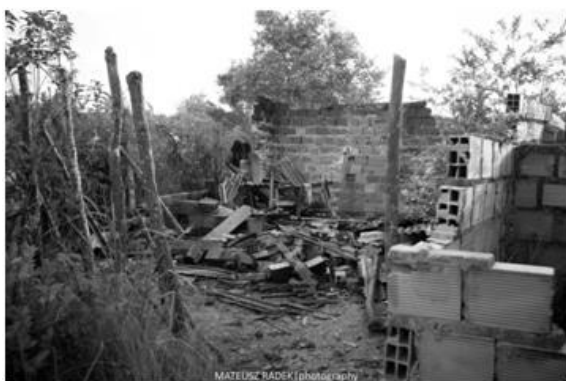
Foto 4: Habitação que foi demolida.
