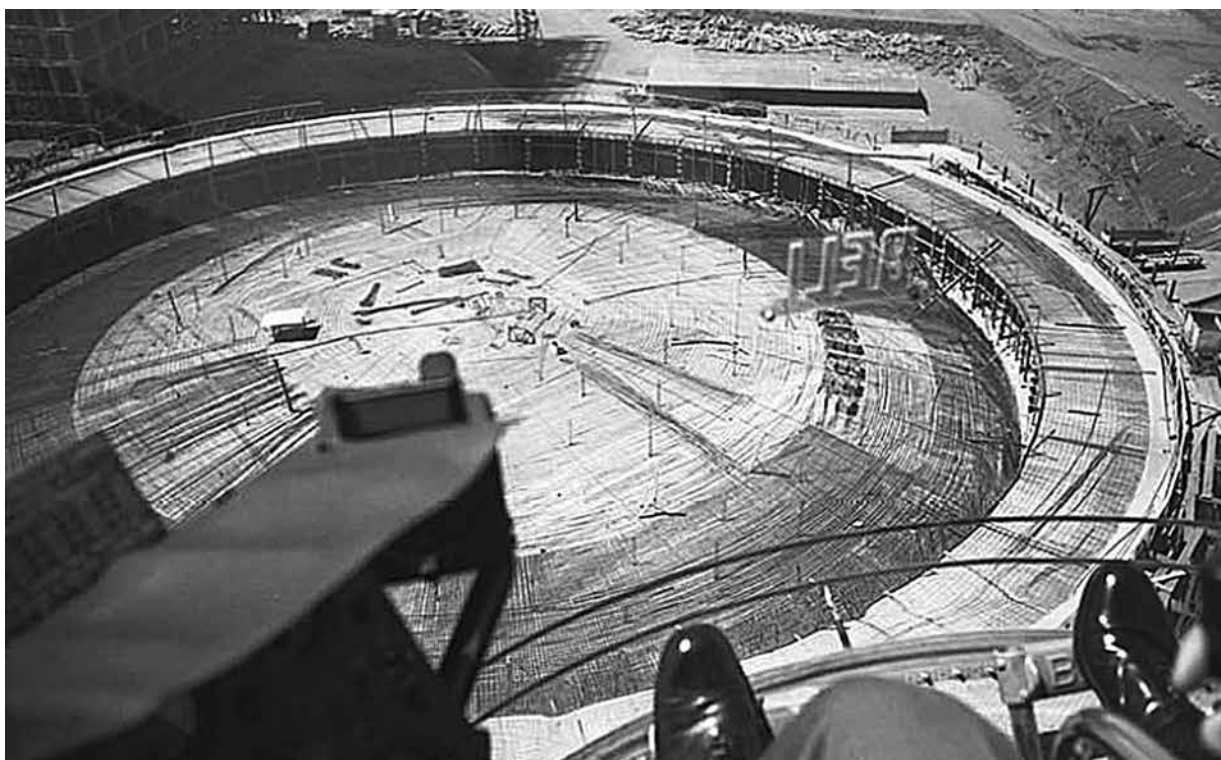
Figura 24: Armação da casca hemisférica de cobertura da cúpula da Câmara Federal. Fotografia: Mario Fontenelle.
