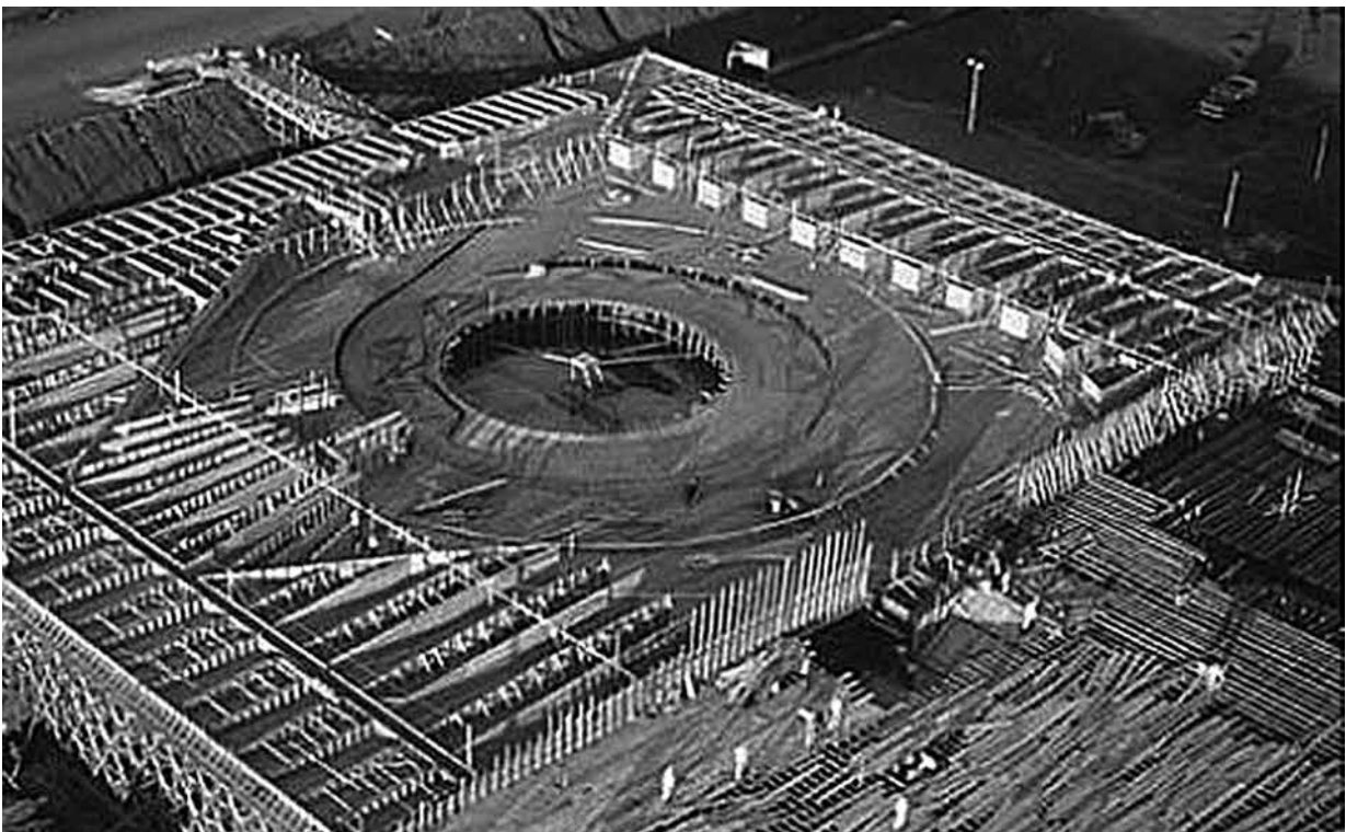
Figura 6: Forma da base junto à cúpula do Senado. Fotografia: Mario Fontenelle.
