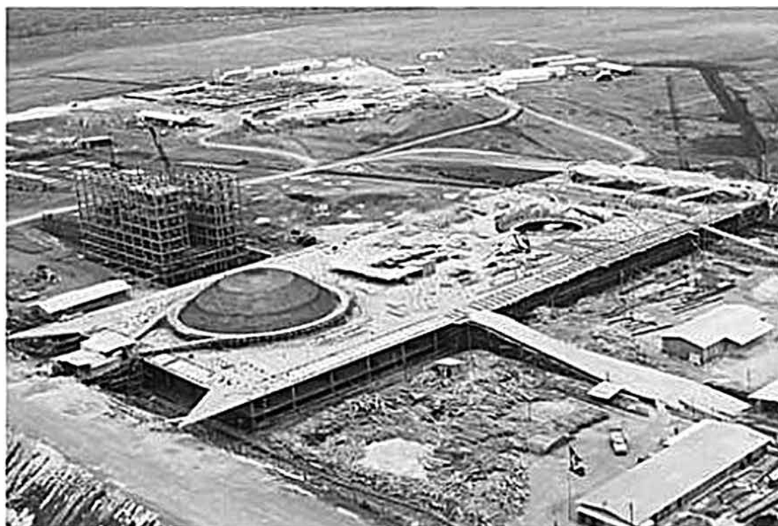
Figura 8: Cúpula do Senado concretada. Fotografia: Mario Fontenelle.
