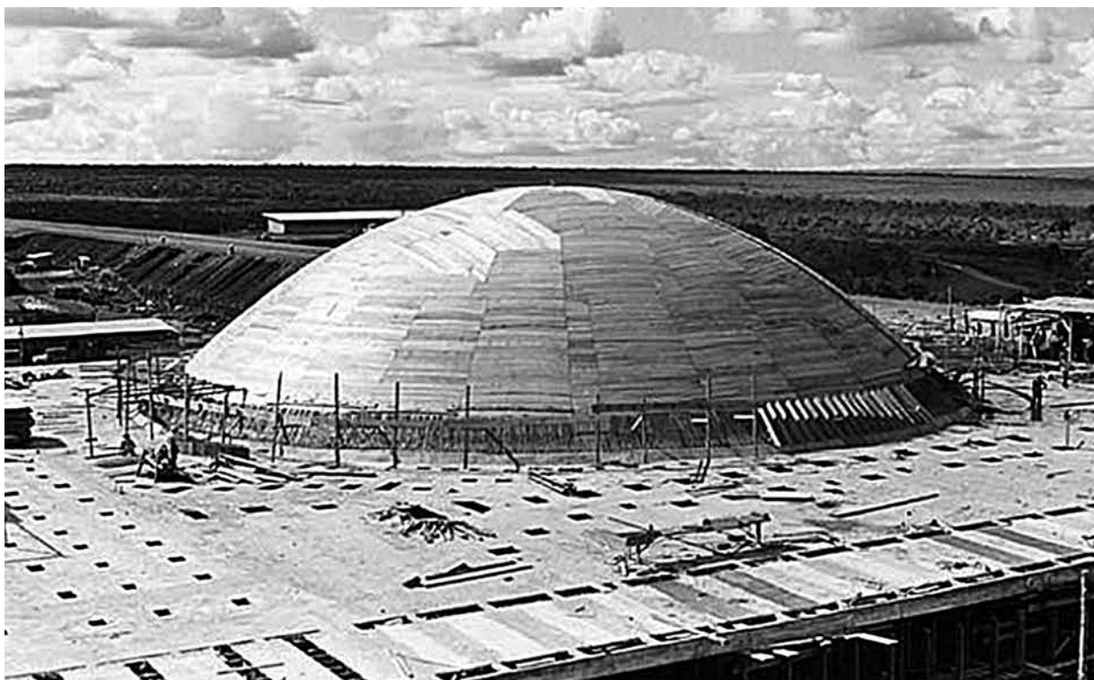
Figura 7: Forma do domo do Senado pronta para receber armação e concretagem. Fotografia: Mario Fontenelle.
