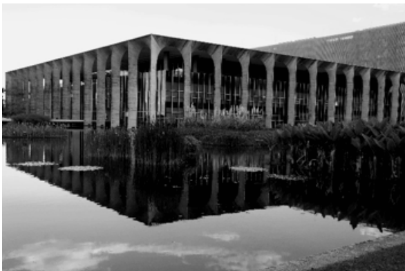
Figura 5: Palácio Itamaraty – Fachadas Norte e Oeste
