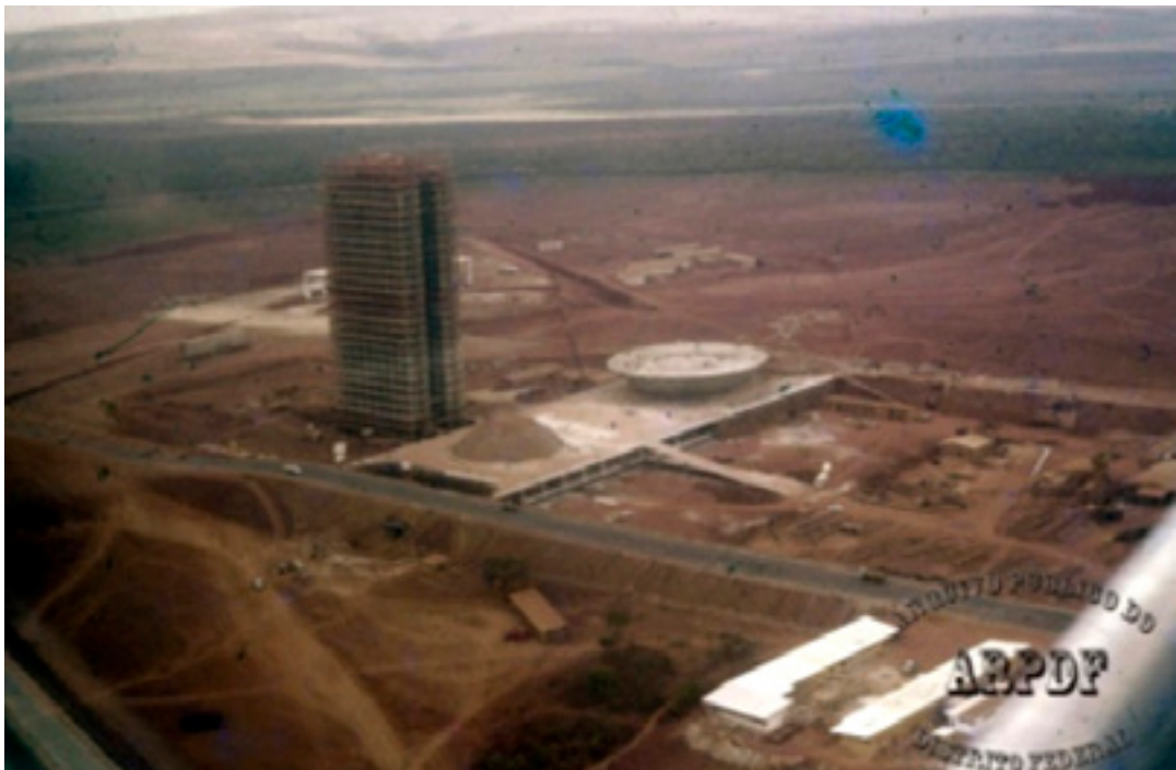
Foto 3: Construção do Congresso Nacional (1956-1960)
