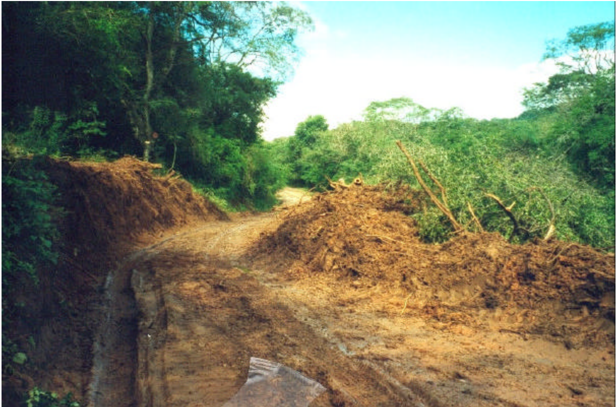
Foto 12 - Habilitación del camino a las Lanzitas luego de su obstrucción por una avalancha de detritos.
