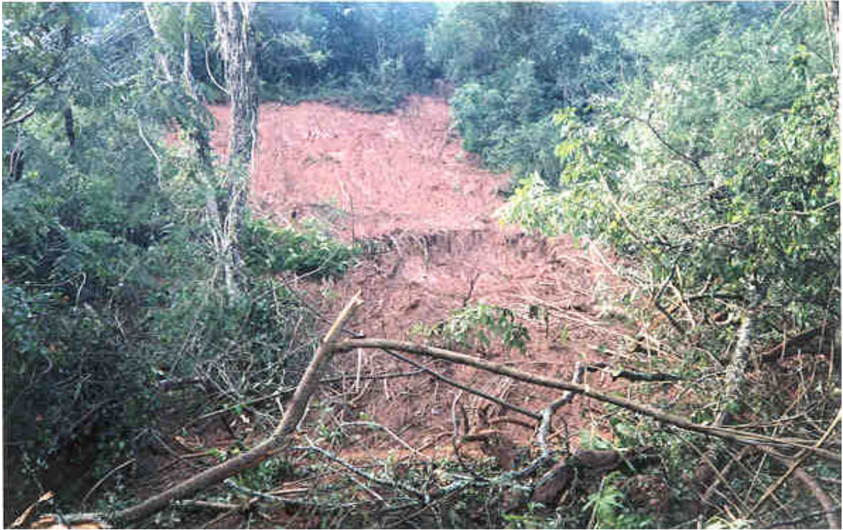
Foto 11 - Avalanchas de detritos en las friables sedimentitas de la Fm Orán (Terciario). Camino entre arroyo Colorado y el puente de Villamonte sobre el arroyo Santa Rita.
