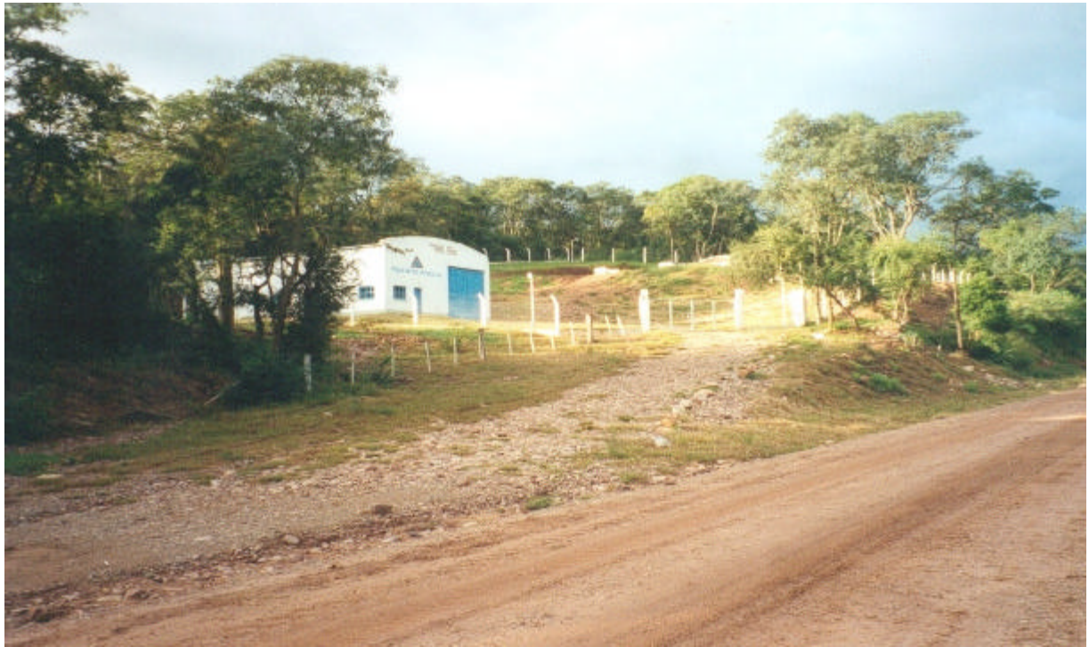
Foto 21 - Planta potabilizadora (Isla Chica) que abastece de agua potable a la zona de Palma Sola y Puesto Nuevo. Su ubicación en un terreno más elevado evitó que sufriera daños.
