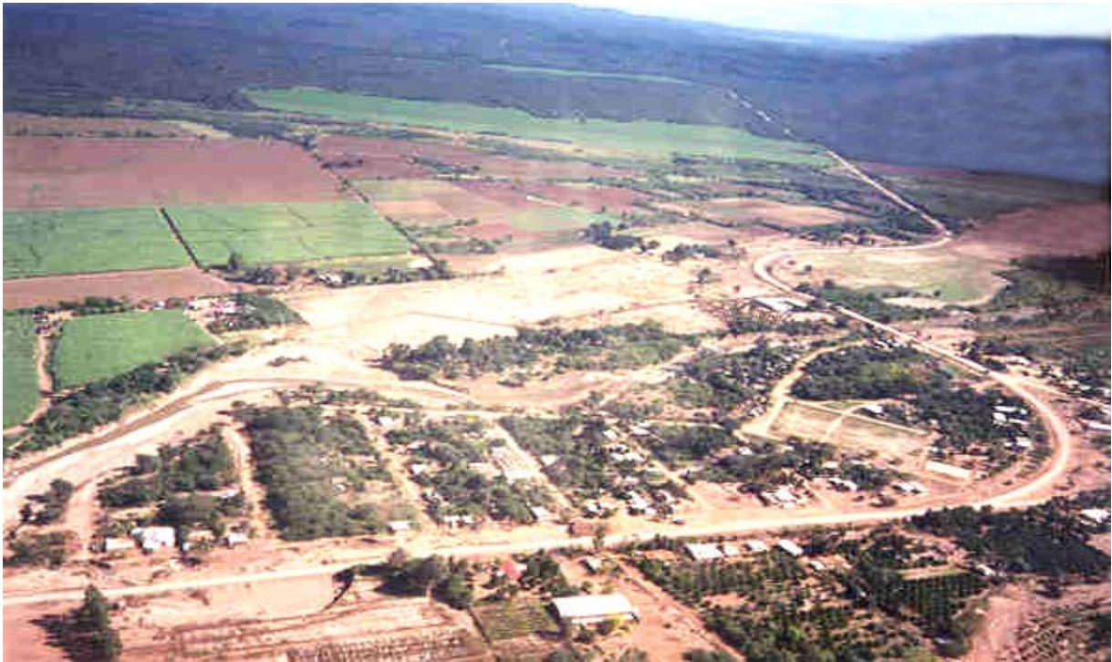
Foto 26 - Vista aérea del tramo de sobreimposición de las rutas provinciales n° 6 y 81 y del puente de Puesto Nuevo (en círculo) sobre el arroyo Santa Rita, situado entre las dos amplias curvas de las citadas rutas.
