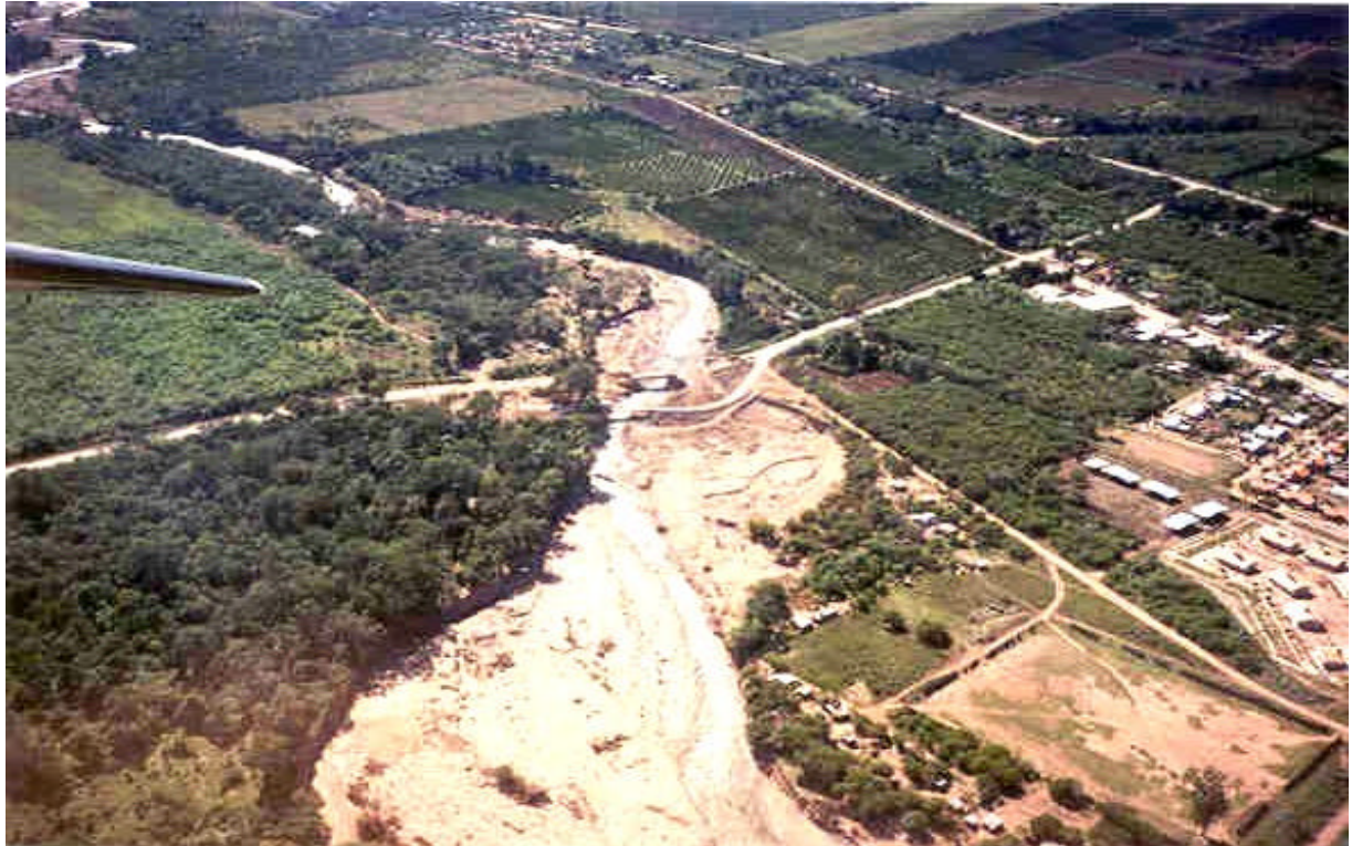
Foto 23 – Vista aérea del puente de Palma Sola. Aguas arriba (hacia el observador) aparece la zona que albergó una efímera laguna por endicamiento. También se vé el puente tipo Bailey construído para salvar el obstáculo representado por el arroyo Santa Rita.
