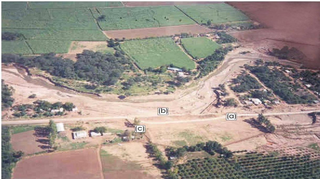
Foto 32 - Vista aérea. Detalle del punto de ingreso (a) del "ramal" principal del aluvión a Puesto Nuevo. Se comprueba la peligrosa cercanía de la traza de la ruta provincial n a 6 (b) a la pendiente de corte del arroyo. Esta situación se repite con el canal de riego c) de Puesto Nuevo.
