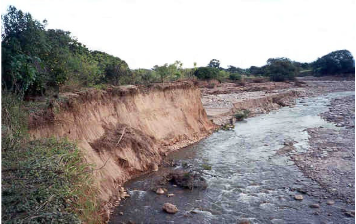
Foto 27 - Arroyo Santa Rita en el paraje Aguas Negras. Se observa fuerte erosión en la curva externa de la sinuosidad acompañada por caídas y deslizamientos de detritos promovidos socavamiento basal.
