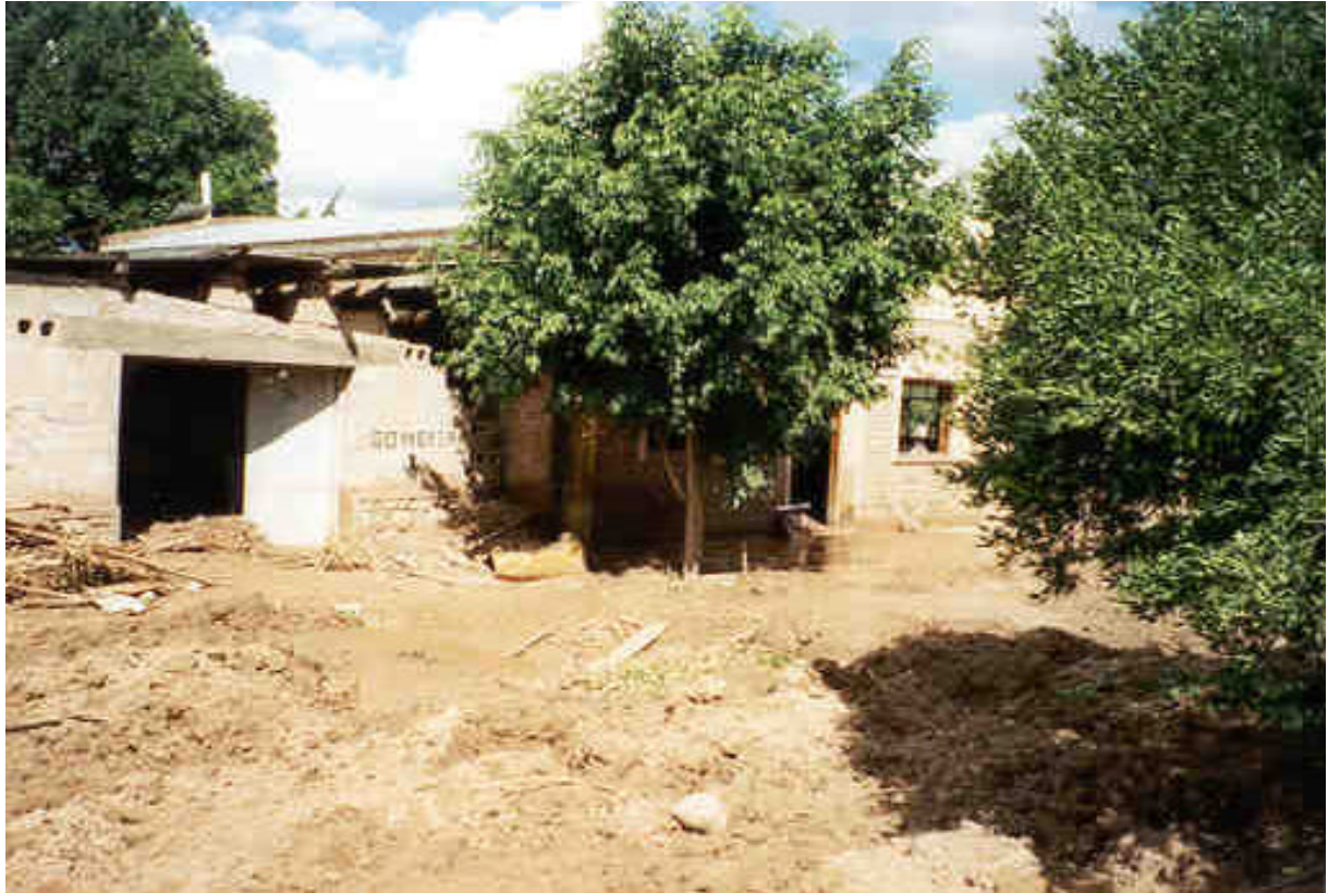
Foto 37 - Invasión de viviendas de Puesto Nuevo (situadas al este de la ruta provincial n a 6) por los enlames del “ramal” principal.
