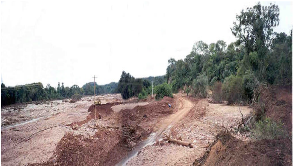
Foto 16 Obras de reparación del camino y construcción de un nuevo puente a la latitud de la desembocadura del arroyo Colorado al arroyo Santa Rita.
