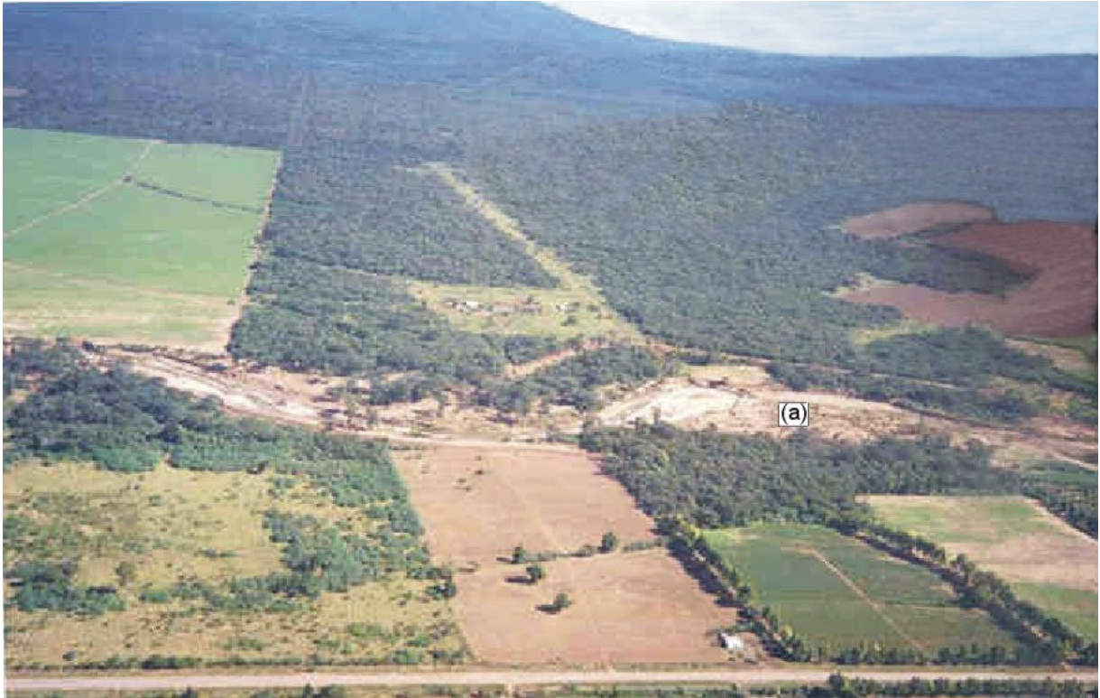
Foto 30 - Vista aérea de los enlames en la zona de la Finca Marrás. (a)
