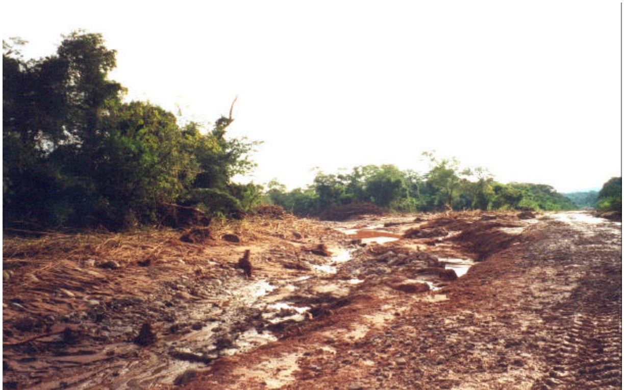
Foto 18 - Destrucción del camino a Villamonte (por Las Lanzitas), por carcavamiento lateral del arroyo Aguada del Zorro.
