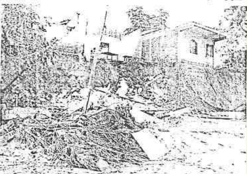
El estado de destrucción total en el que quedó esta vivienda, es una muestra del de los sismos de tierra que afectó al sur de Jujuy y al avance de los escombros en Palma Sola.
