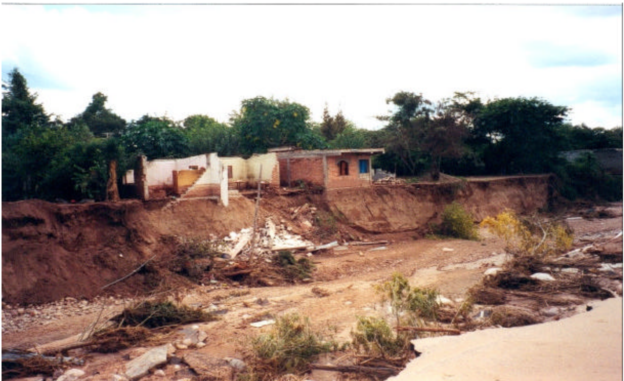
Foto 36 – Destrucción de viviendas por erosión lateral y caídas durante el desarrollo de la cárcava.
