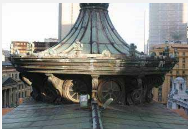
Figura 4 Lanternim; a) Área onde foram feitas as análises do cobre e dos resíduos de douramento; b) Camada de douramento do friso do Lanternim; c) Coleta dos resíduos de douramento na região da Caixilharia do basculante do Lanternim. Fonte: Campos (2008)
