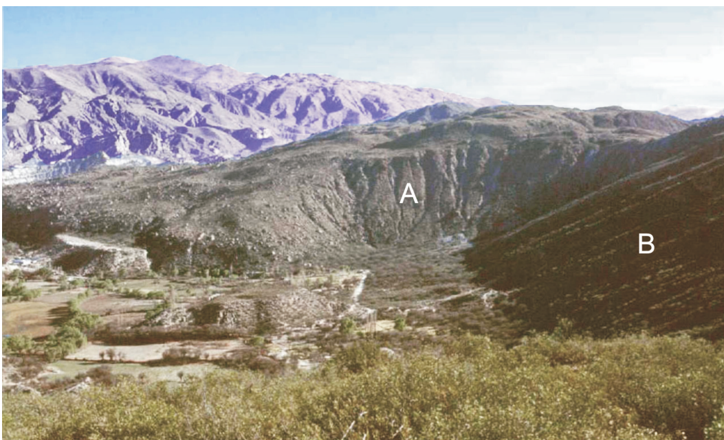
Fotografía 2. Vista hacia el norte desde la parte superior del deslizamiento VI. Detrás de las fincas puede apreciarse la altura, el volumen (y la distancia de viaje) del deslizamiento V (A). La ladera inclinada (B) que se halla a la derecha, es la losa inestable que podría deslizarse con gran riesgo para la localidad.
