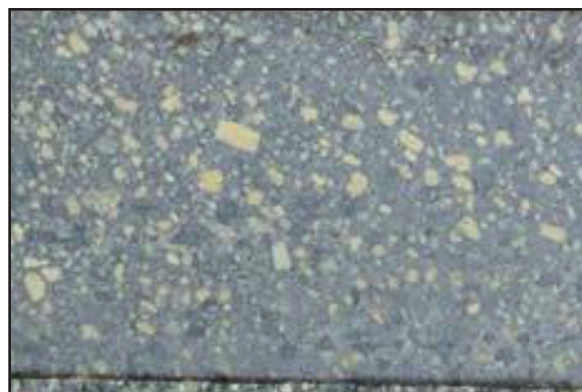
Figura 22. Pórfiros intrusivos con alteración propilítica con destrucción selectiva de plagioclasa a arcilla
