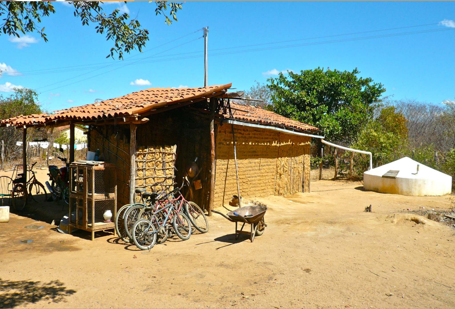
Cisterna do programa federal "Um Milhão de Cisternas" (P1MC), Parnaguá (Piauí, maio 2012).
