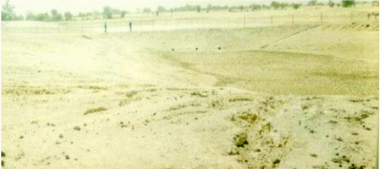
Photo 2. Photo d'une mare aménagée ( Piterki ) après la saison des pluies. Des sillons indiquent l'érosion hydrique et l'ensablement récurrent (Sy, 2003)
