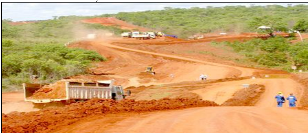
Figura 8 - Trecho em construção da FIOI. Fonte: BAMIN, 2010
