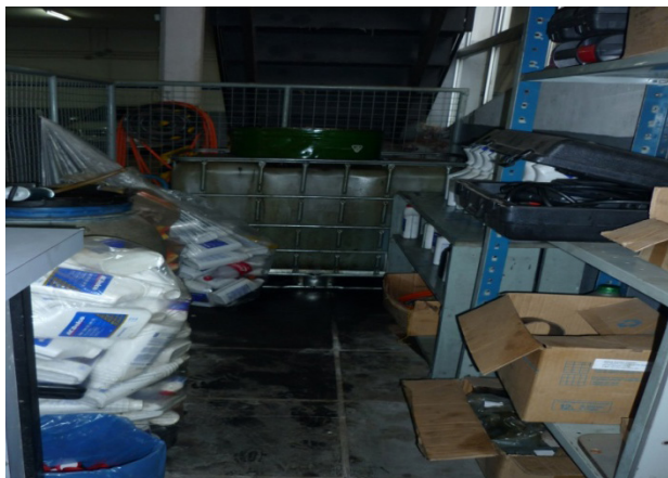
Figura 14. Manchas de óleo próximas ao reservatório de óleo lubrificante. contenção.
