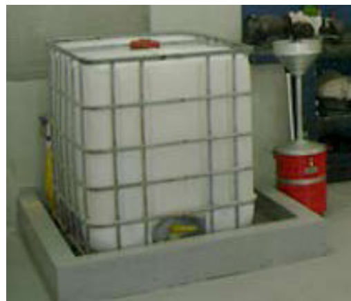
Figura 13. Container em bacia de contenção Fonte. ABRAMAC, 2008.
