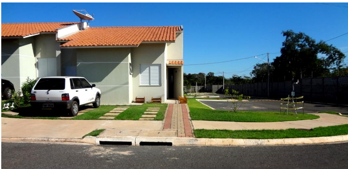
Figura 01 – Edificação recebendo radiação direta em uma lateral
