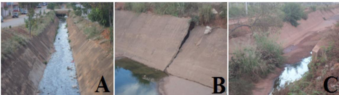
Figuras 2 – (A) Elemento de Macrodrenagem, o canal do córrego das Melancias, (B) Calha do canal com rachadura e (C) Erosão e assoreamento no canal do córrego Melancias.
