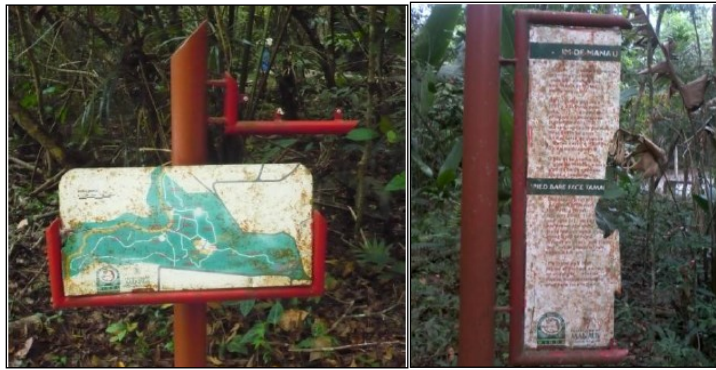
Figura 18. Grau de deterioração das placas no parque do Mindu.
