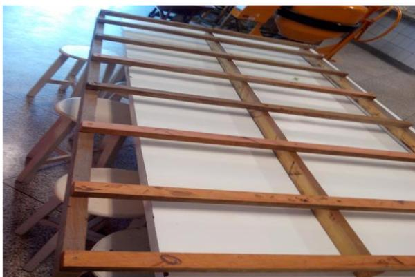
**Figura 4.** Estrutura de suporte da cobertura.
