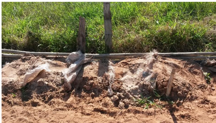
Figura 3. Estrutura de bioengenharia após seis meses de implantação.
