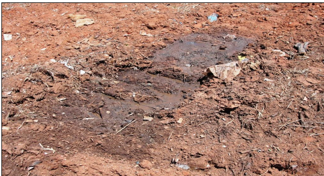
Figura 3. Chorume aflorando na superfície de vala no aterro de Presidente Venceslau em 2014.
