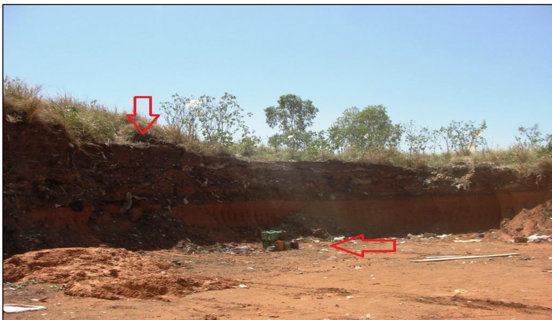
Figura 4. Talude geotécnicamente instável e resíduo sólido depositado a céu aberto no aterro de Presidente Venceslau em 2014.
