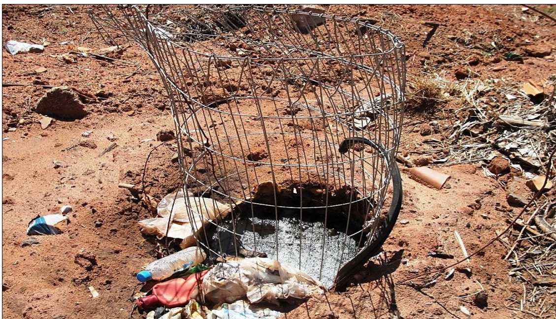
Figura 2. Chorume entupindo o poço de captação no aterro de Presidente Venceslau em 2014.
