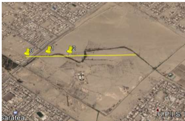
Figura 3. Línea de Transmisión LT-1112 de 138 Kv, que pasa por el Campus 2 de la UNS. Fuente: Google Earth
