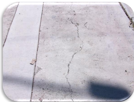
Figura N° 11: Grietas longitudinales
