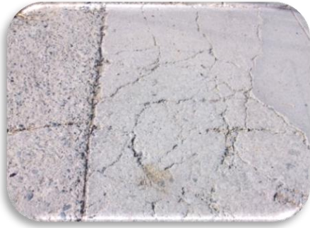
Figura N°: 29 Medición descascaramiento de junta > 10 (Av. central) > 30 años de vida útil – suelo: arena arcillosa
