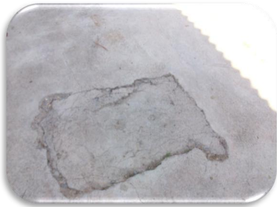
Figura N° 20: Parches deteriorados
