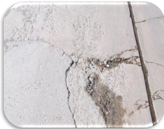
Figura N° 16: Levantamiento localizado
