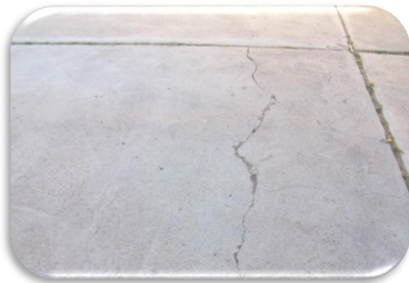
Figura N° 12: Grietas transversales
