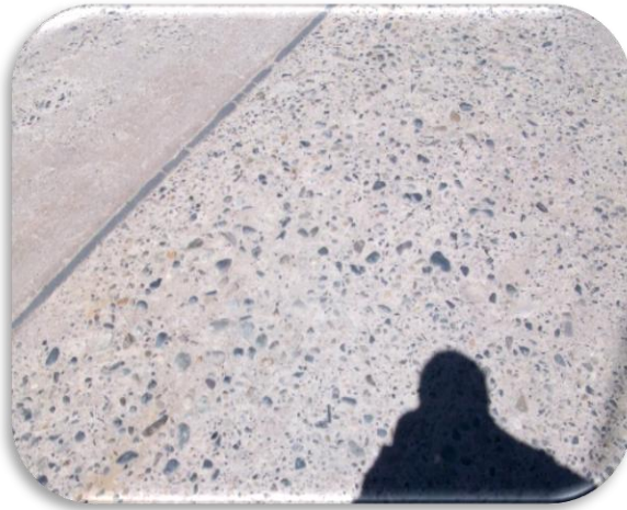
Figura N° 14: Desintegración
