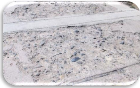
Figura N° 27: Medición de pulimento de agregados > 10 paños divididos (Jr. Amancaes intersección con Víctor Vález) > 25 años de vida útil – suelo: arena arcillosa Fuente: Elaboración propia
