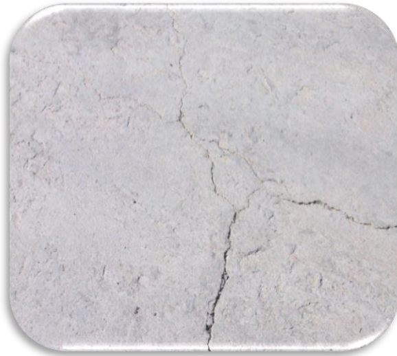
Figura N° 10: Grietas diagonales
