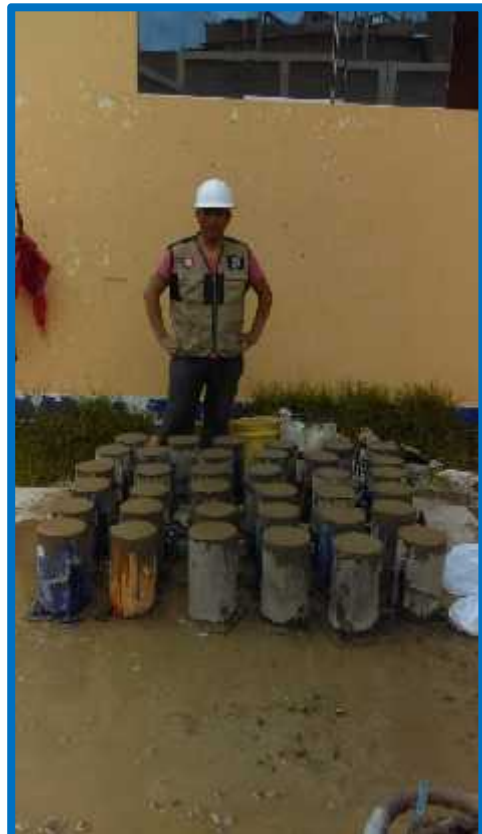
Foto 24 Terminado de vaciado a probetas
