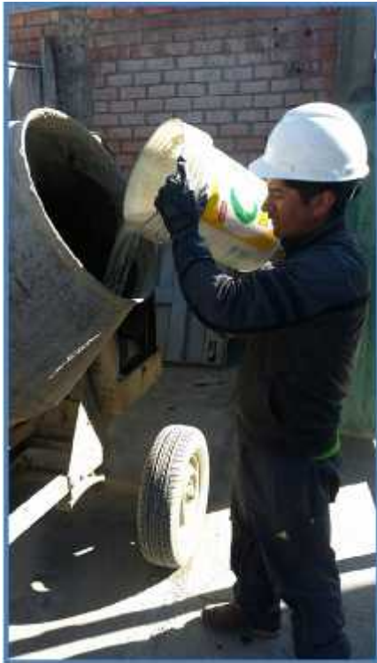
Foto 20 Llenando materiales para el mezclado
