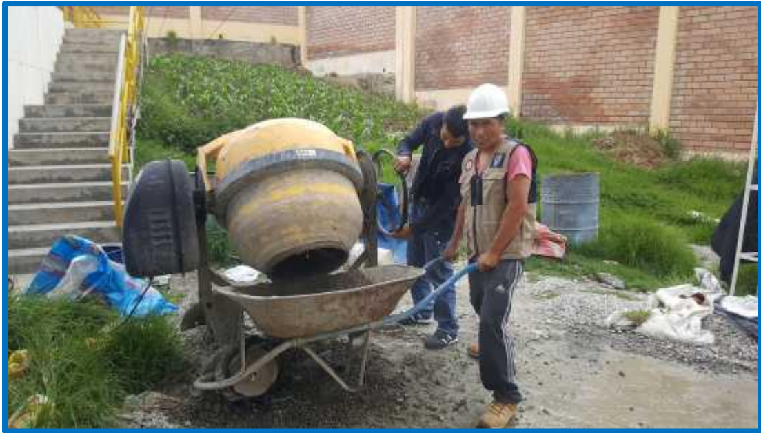
Foto 22 Vaciado de mezcla a carretilla.
