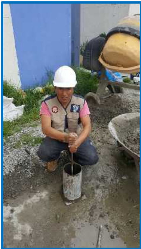
Foto 23 Vaciado de mezcla a probeta
