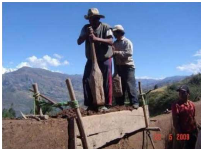
Figura 02: Construcción de ilera de tapial.
