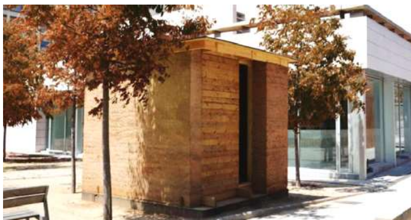
Figura 15: Prototipo de vivienda construida e instrumentada para para el estudio de su comportamiento termihigometrico - Casa S-Low.
