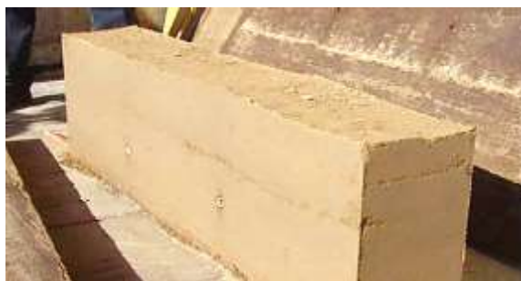
Figura 13: Módulo de tapia, las dimensiones son de 0.40 a 0.60m de ancho x 1.60 x 1.80 m de largo. Para completar una grava se rellenan 4 capas de 20cm que se compactan una por vez hasta 15cm.
