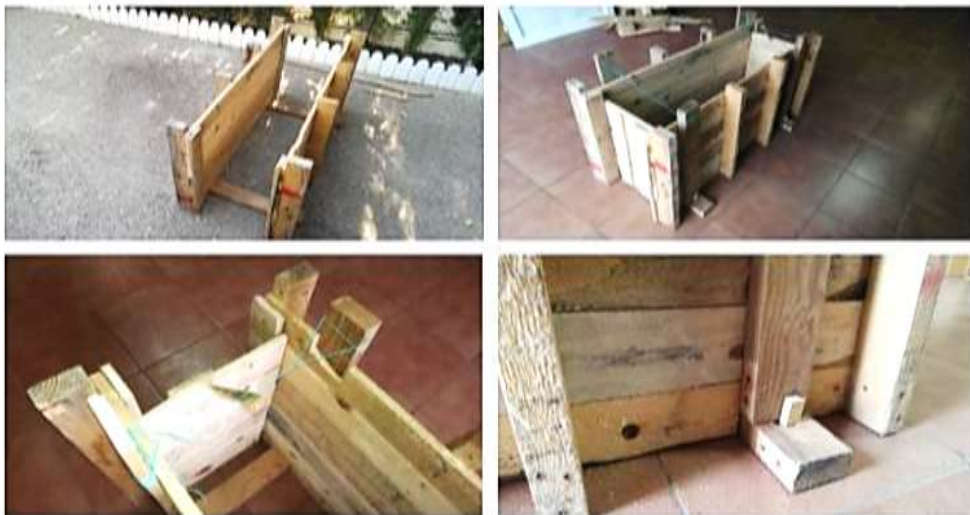
Figura 47: Proceso de elaboración de un tapial (encofrado) y detalles.
