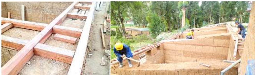
Figura 11: La viga collar, sistema reforzado.
