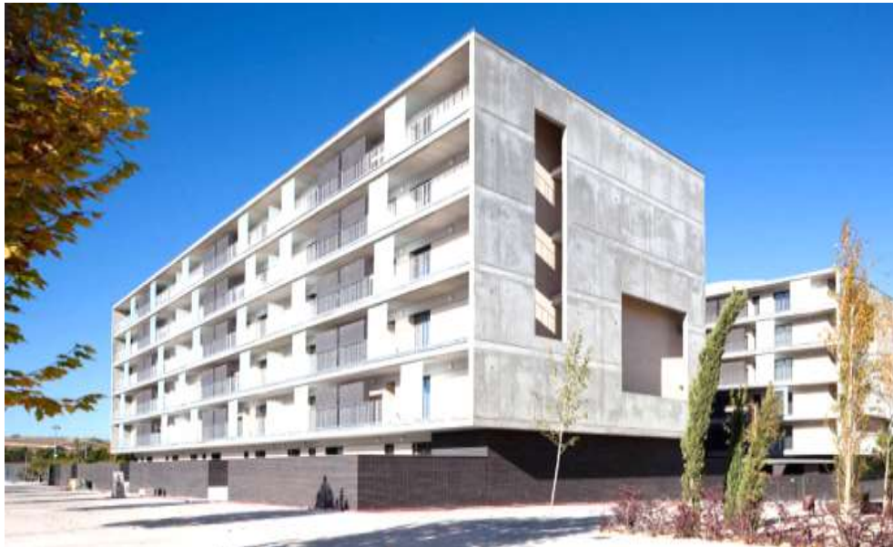
Figura 43: Bloque de viviendas colectivas en el Eco barrio.
