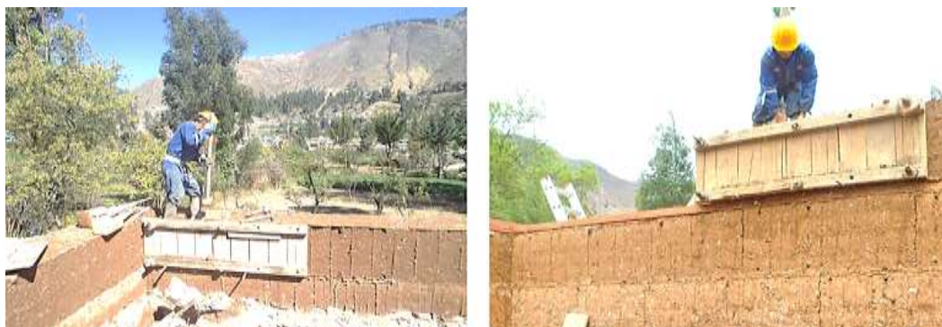
Figura 12: Construcción del muro de tapial reforzado con viga collar.
