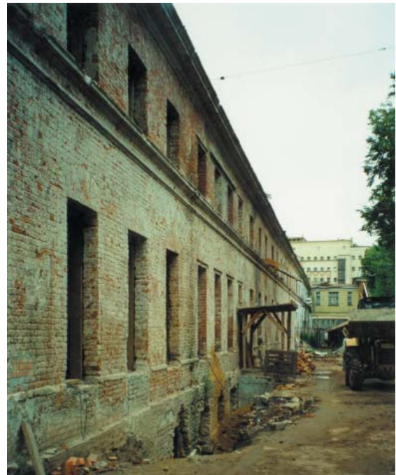
Здание ожогового центра в период реконструкции
