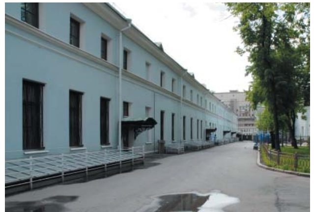
Здание ожогового центра после реконструкции
