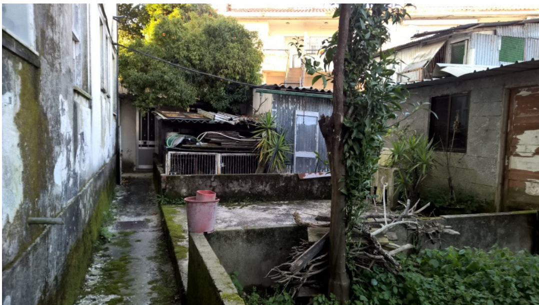
Fotografia 2- Logradouro do Edifício do Tipo 9 da Série III, Bairro Tarrafal, Guimarães
