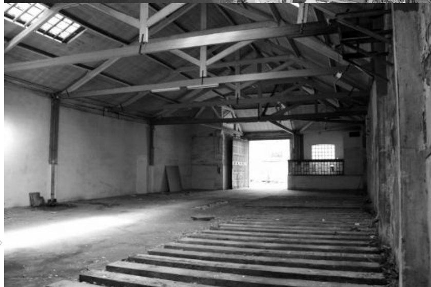
Antes - Interior do edifício ligado à indústria das conservas.
