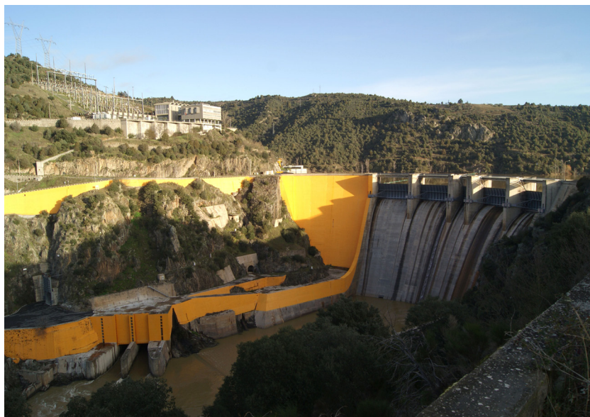
Barragem de Bemposta, 2014.
