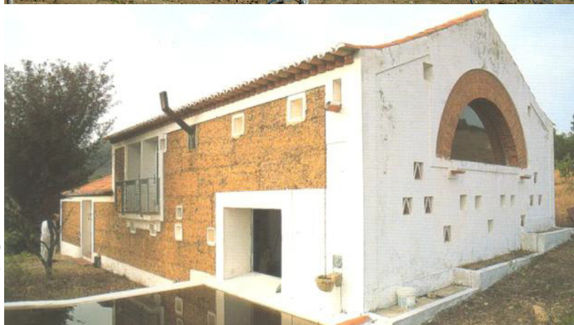
Atelier S. Luís, Odemira pelo Arq. Alexandre Bastos, 1995. Construção em Taipa.
