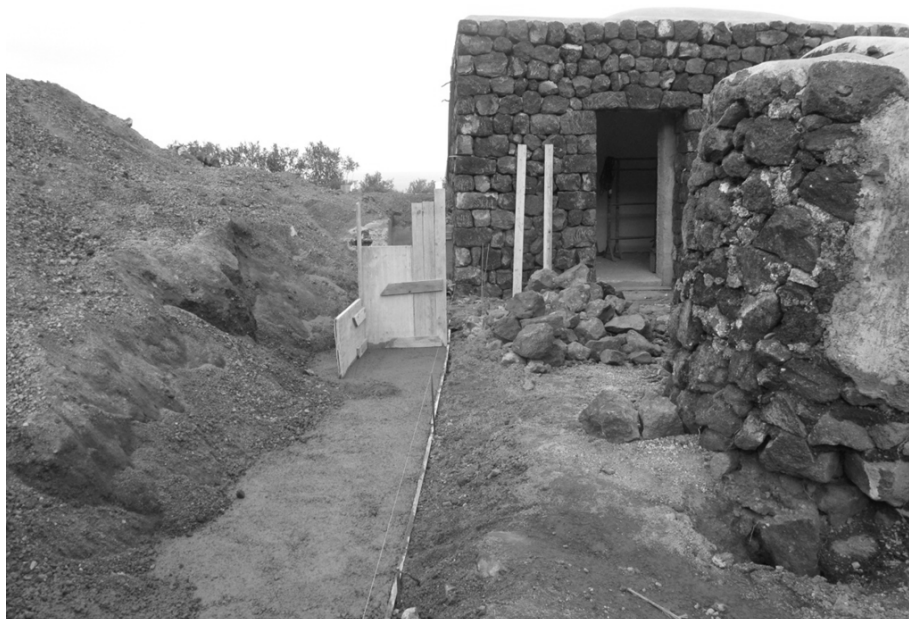
Ilustração 68 – Ampliação do dammuso Sacco revestido com pedra lávica local (Cedida por: Anna Sacco).
