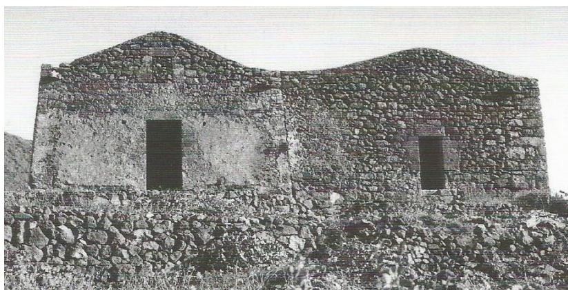
Ilustração 64 – Edifício com cobertura à schiena d'asino , ex-Chiesa di San Francesco, em localidade Piano di Ghirlanda (D'Aietti, 2009).
