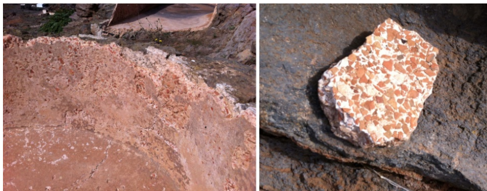
Ilustração 32 – Cocciopesto para impermeabilização das cisternas (Ilustração nossa, 2013).
