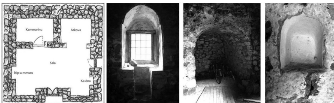
Ilustração 78 – A esquerda: esquema de célula base do dammuso (Serafino, 2009 p. 24); à seguir, uma sequência de imagens do interior da célula base do dammuso Bonomo em localidade Bugeber : janela, alcova, nicho votivo (Ilustração nossa, 2013).
