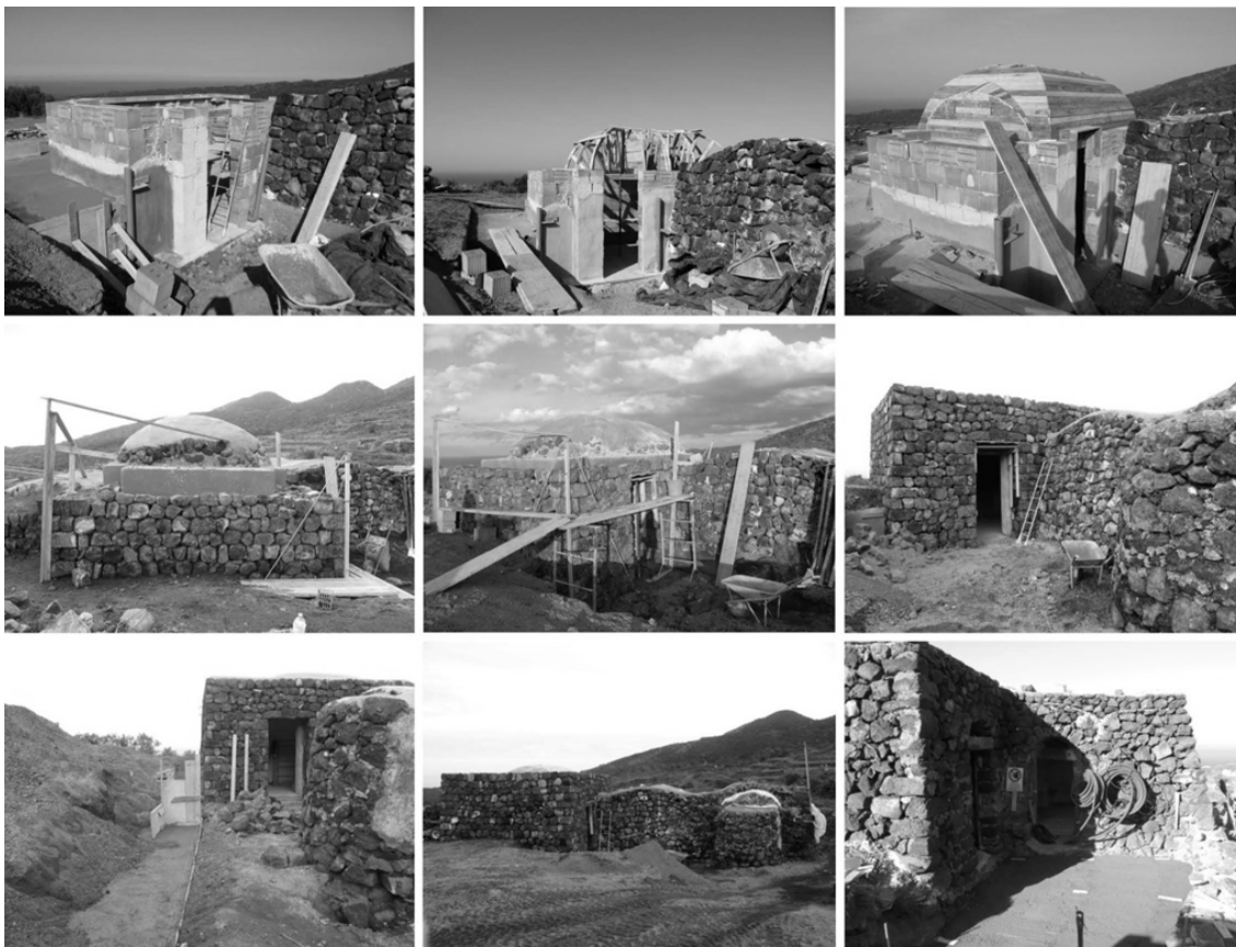
Ilustração 109 – Sequência de imagens do processo construtivo da ampliação (Cedida por A. Sacco).
