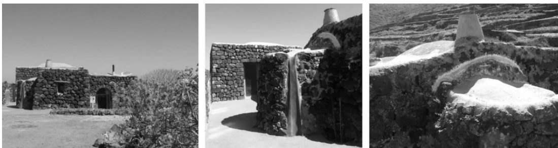
Ilustração 110 – Imagens exteriores da obra acabada (Cedida por A. Sacco).
