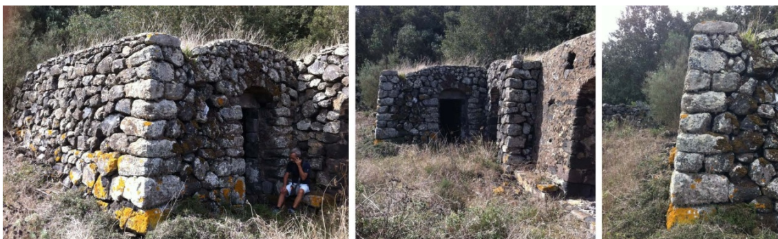
Ilustração 63 – Dammuso com as paredes exteriores com plano inclinado (Ilustração nossa, 2013)
