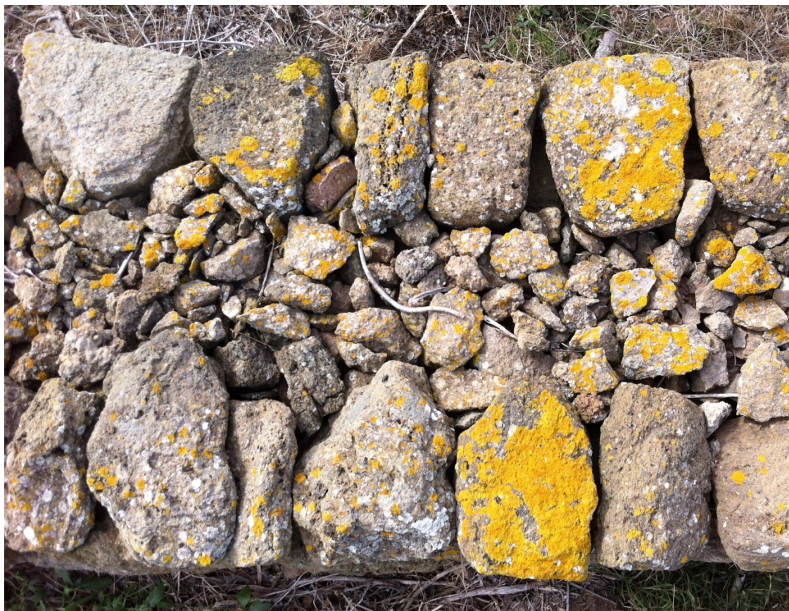
Ilustração 48 – Exemplo de muro com estrutura a ccasciáta (Ilustração nossa, 2013)
