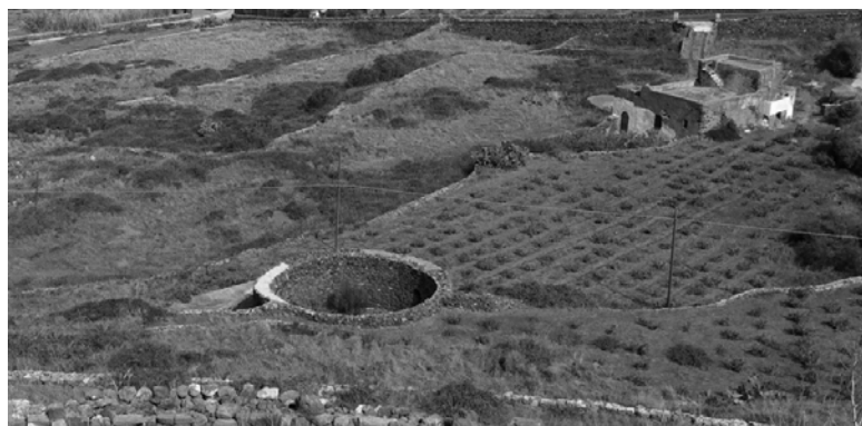
Ilustração 52 – O jardim constitui parte integrante do muro de contenção dos terraços agrícolas (Ilustração nossa, 2013).
