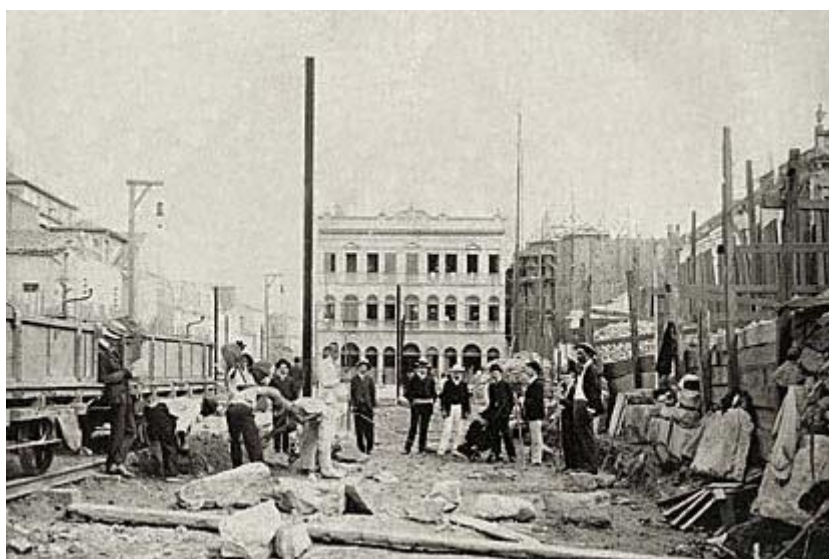
Ilustração 5 – Demolições para a Construção da Av. Central, 1904 – 1905 (Portal Arquitetónico, 2011)
