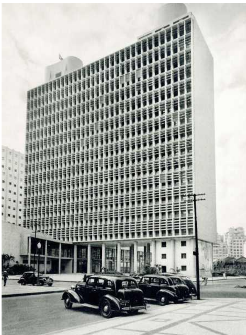
Ilustração 26 – Fachada Norte do edifício do Ministério da Educação e Saúde (Imgrum, 2016)
