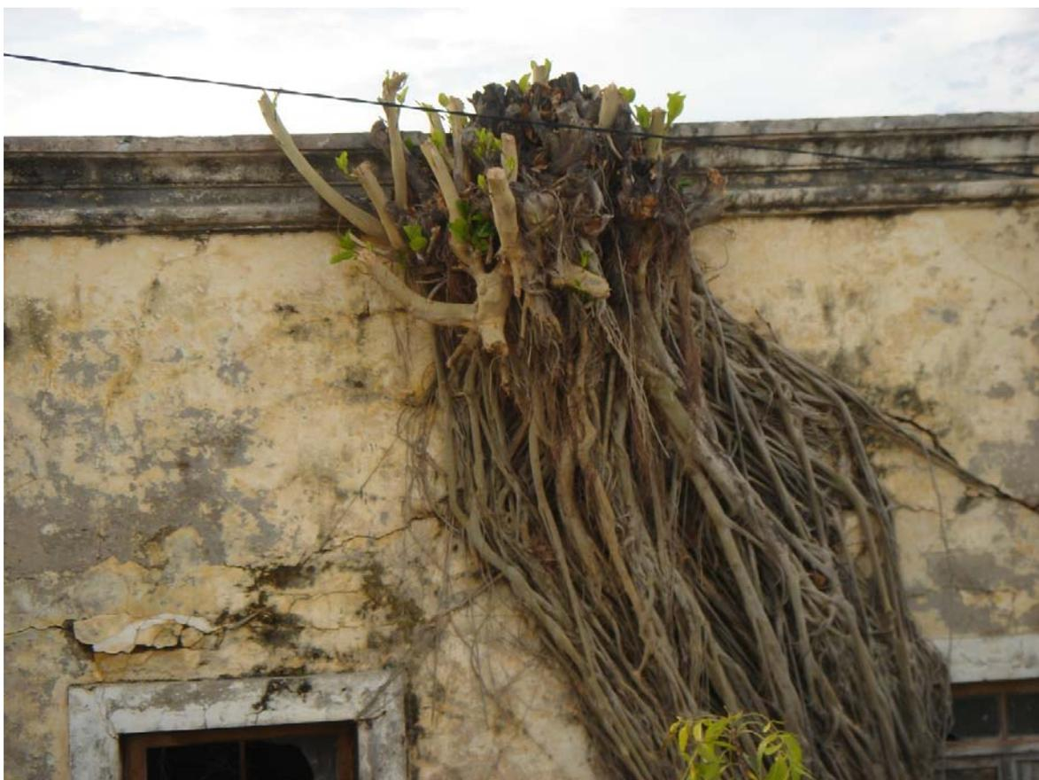
Figura 40 | Penetração de raízes no edificado, Ilha de Moçambique, 2009<sup>230</sup>.
