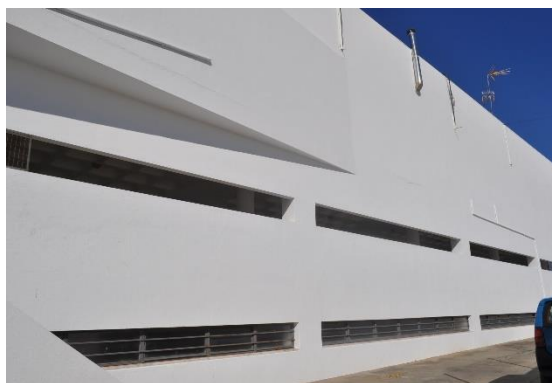
Ilustração 93 – Alçado Nascente com a indicação dos planos que descarregam nas aberturas horizontais. (Ilustração nossa, 2016).
