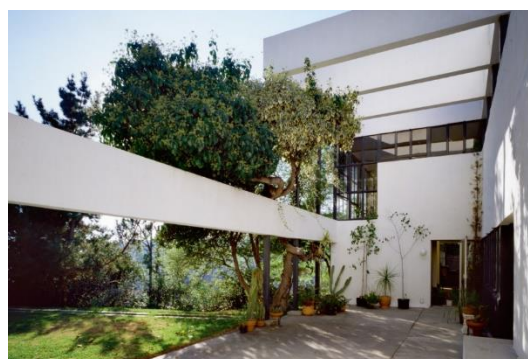
Ilustração 38 – Plano suspenso junto ao pátio exterior. (Column, 2015)
