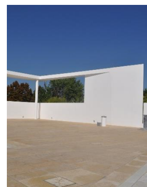
Ilustração 97 – Pormenor do Alçado Poente, o plano que paira sobre os pilares converte-se num plano vertical. (Ilustração nossa, 2016).
