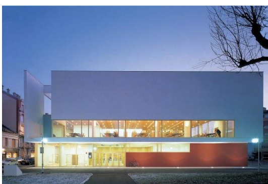
Ilustração 73 – Plano suspenso de fachada da Biblioteca Lucien Febvre. (Beaudoin Architectes, 2016e).
