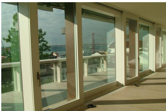
Ilustração 167 – Pormenor interior das janelas do projecto de habitação da Rua Presidente Arriaga. (www.jjteixeira.pt, 2013)
