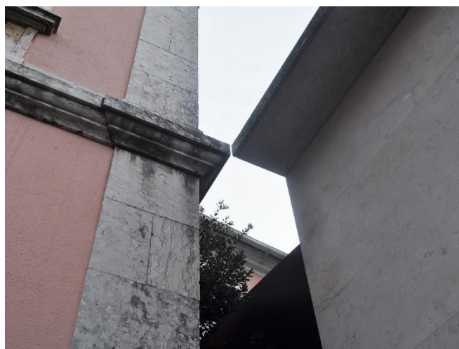
Ilustração 125 – Pormenor das pedras, do elo de ligação do edifício da DSDA com o Palácio. (Ilustração nossa, 2016).
