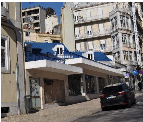
Ilustração 156 – Lote de intervenção visualizado da Avenida da Liberdade. (Ilustração nossa, 2013).
