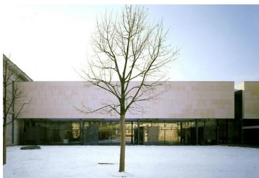
Ilustração 82 – Plano suspenso de fachada do Museu de Belas Artes em Nancy. (Beaudouin Architectes, 2016a).
