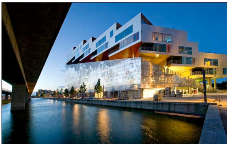
Figura 41 – Autor: Jems Lindhe - “Fotografia sobre a fachada, mostrando o espaço dedicado ao estacionamento e às habitações no volume superior.” (Fonte: http://www.archdaily.com/15022/mountain-dwellings-big/1582909419_mtn-jens-lindhe-02/ )
