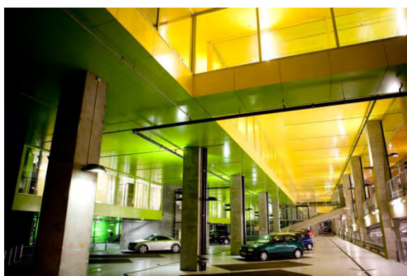
Figura 44 – Autor: Ulrik Jantzen - "Fotografia mostrando a zona de estacionamento, com acesso directo as habitações." (Fonte: http://www.archdaily.com/15022/mountain-dwellings-big/1481898904_mtn-ulrik-jantzen-05/ )
