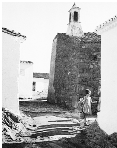
Ilustração 38 - Arquitectura de habitação: Povoado - contraste entre as paredes de xisto à vista e rebocadas, Giões. ([Adaptado a partir de:] Martins, Castro e Torres, 1988, p. 153)
