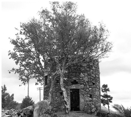
Ilustração 116 - Moinho antes da intervenção, Vilar de Mouros, Caminha, 1989. ([Adaptado a partir de:] Gigante, 2017)
