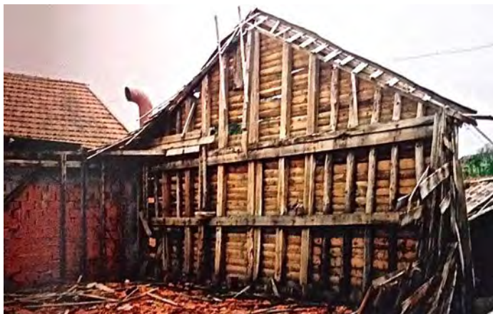
Ilustração 60 - Casa de Madeira: elementos verticais e horizontais da parede. ([Adaptado a partir de:] Vaz, 2010, p. 49)
