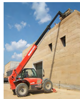
Ilustração 79 - Construção actual em taipa: elevação de paredes com sistemas mecânicos actuais, Herdade do Rocim - Adega em Cuba. Carlos Vitorino, 2007. ([Adaptado a partir de:] Betão e Taipa, 2009)
