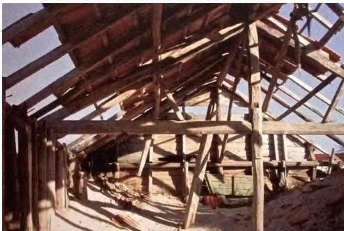
Ilustração 58 - Casa de Madeira: estrutura da cobertura, palheiro de Tocha, Cantanhede. ([Adaptado a partir de:] Vaz, 2010, p. 55)
