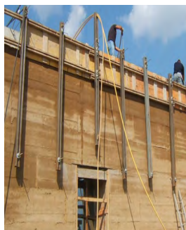
Ilustração 79 - Construção actual em taipa: elevação de paredes com sistemas mecânicos actuais, Herdade do Rocim - Adega em Cuba. Carlos Vitorino, 2007. ([Adaptado a partir de:] Betão e Taipa, 2009)
