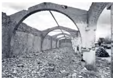
Ilustração 170 - Obra: pórticos que suportam a cobertura da galeria com acesso aos futuros quartos. ([Adaptado a partir de:] Co, 2017)
