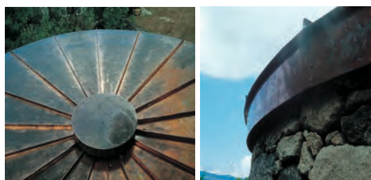
Ilustração 121 - Cobertura em cobre. José Gigante, 1996. ([Adaptado a partir de:] Gigante, 2017)
