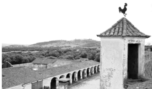
Ilustração 163 - Edifícios agrícolas antes da intervenção. ([Adaptado a partir de:] Lourenço, 2017)
