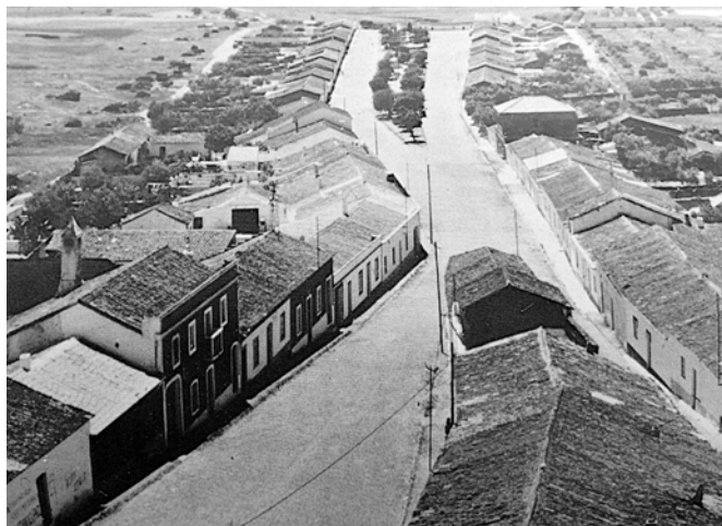
Ilustração 34 - Arquitectura de habitação: Casas do Povoado, Entradas. ([Adaptado a partir de:] Moutinho, 1995, p. 120)
