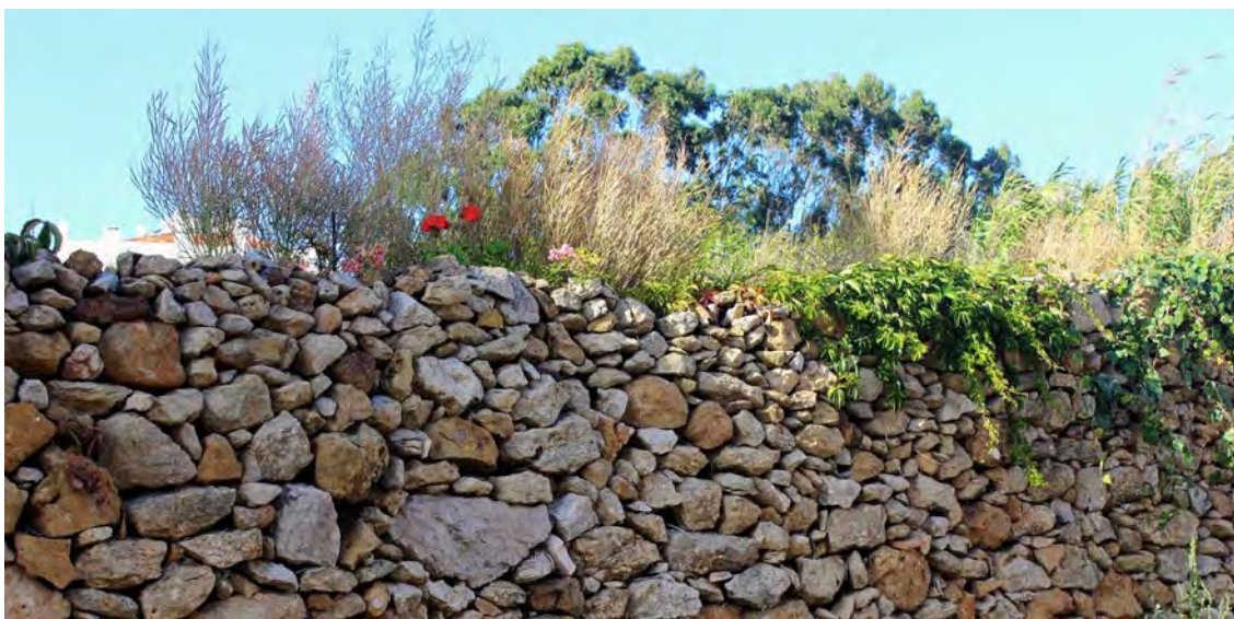
Ilustração 43 - Muro em alvenaria de pedra calcária, Ericeira, Mafra. (Ilustração Nossa, 2017)
