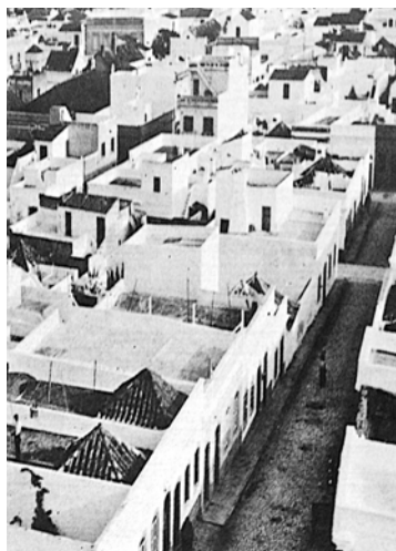
Ilustração 39 - Arquitectura de habitação: Povoado - coberturas mistas, Fuseta, Olhão. ([Adaptado a partir de:] Martins, Castro e Torres, 1988, p. 150)
