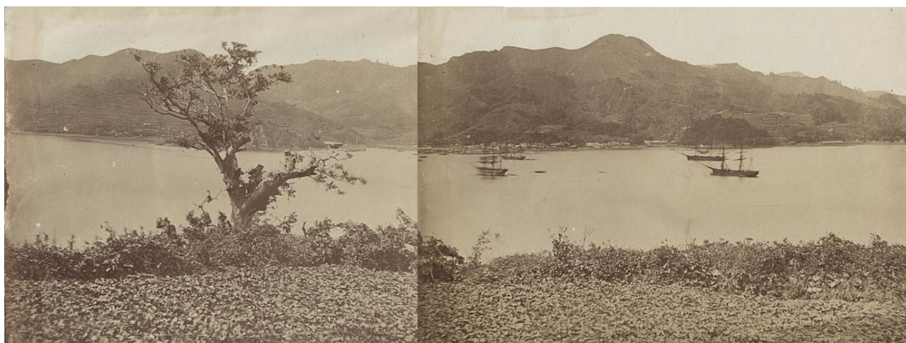
図 5 プレート 3、4。合わせ目付近に飽の浦地区
