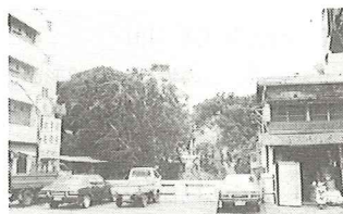
写真-13 某予備校(左)と某ホテル (中央)全景 (台中市)
