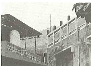
写真-17 廟後の住宅, 吉の例 (台南市)
