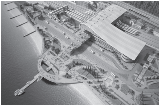
Рис. 5. Вид нового вокзала со стороны моря и многоярусной автостоянки.
