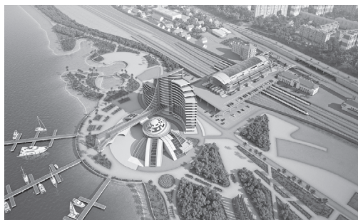
Рис. 2. Вид вокзала со стороны моря. Проект по идее архитектора Ю. М. Орлеанского (ОАО «Мосгипротранс»).
