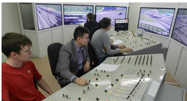
Рис. 2. Оператор второй тормозной позиции 3-го и 4-го пучка регулирует скорости скатывания отцепов в зависимости от веса и пути сортировочного парка.
