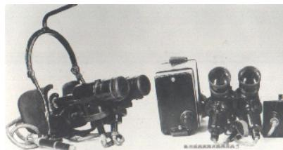
Рис. 4. Приборы ночного видения ОКБ-1, выпущенные Опытным электромеханическим заводом ВЭИ. 1942-1945 гг.
