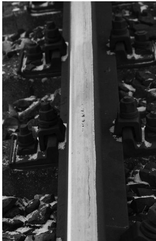
Рис. 3. Рельс с поверхностными дефектами.
