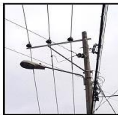
Figura 7. Conductor canastillado y derivación sin estribo
