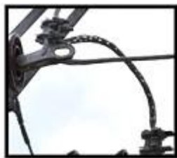
Figura 4. Detalle del conductor canastillado.
