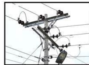
Figura 3. Conductor canastillado.
