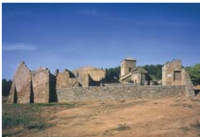
Fig.16. La casa parroquial de Castellnou de Bages después de su restauración, 2000, foto: Montserrat Baldomà, SPAL
