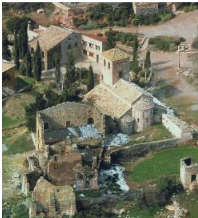
Fig.13. Conjunto de la iglesia de Sant Andreu y las ruinas de la casa parroquial de Castellnou de Bages hacia 1970. SPAL
