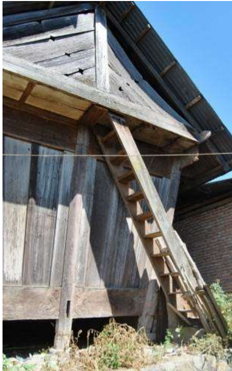
Gambar 3. Model Tangga Bilik Padi Menyamping tanpa Tiang
