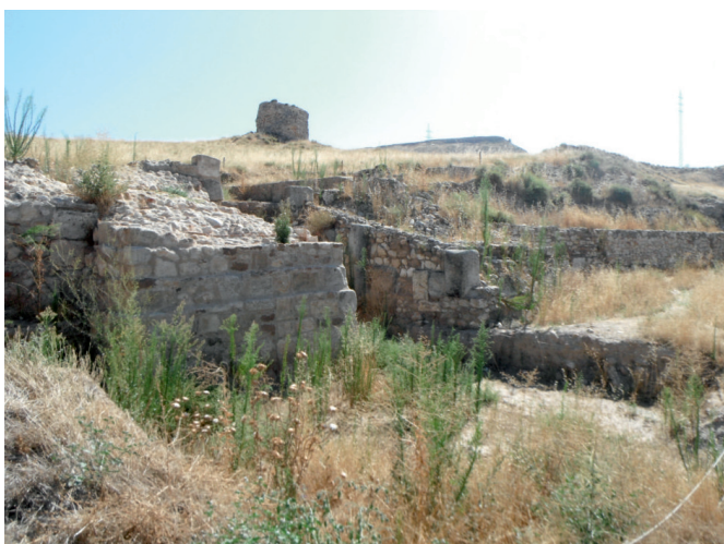
Figura 21. Vista general de la zona de la entrada antes y después de la intervención
