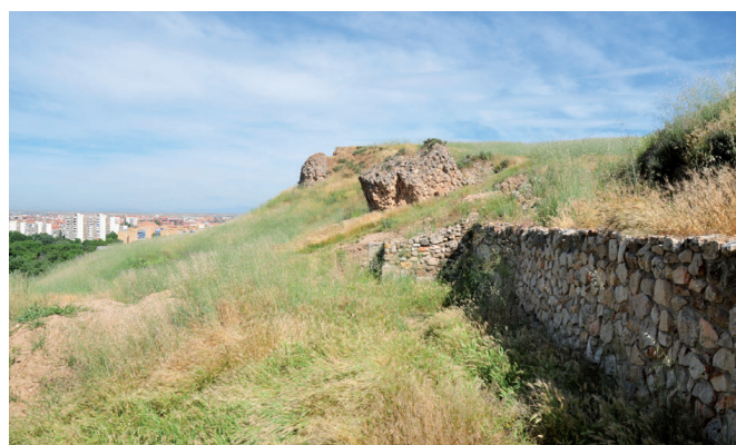
Figura 12. Vista general de la zona de la entrada donde se aprecia el lienzo de muralla rehecho en las primeras campañas de intervención y los restos de las torres 3, 4 y 6. Los aparejos reconstruidos poco tienen que ver con la característica fábrica califal
