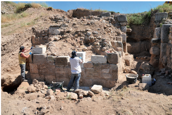
Figura 20. Vista del proceso de restauración de la torre occidental. Se recrearon varias hiladas para reducir la pendiente interior de más del 40% que provocaba el lavado continuo de los morteros por escorrentías pluviales. Los aparejos del recrecido respetan la edificación califal típica sin llevar a error al visitante como en intervenciones anteriores
