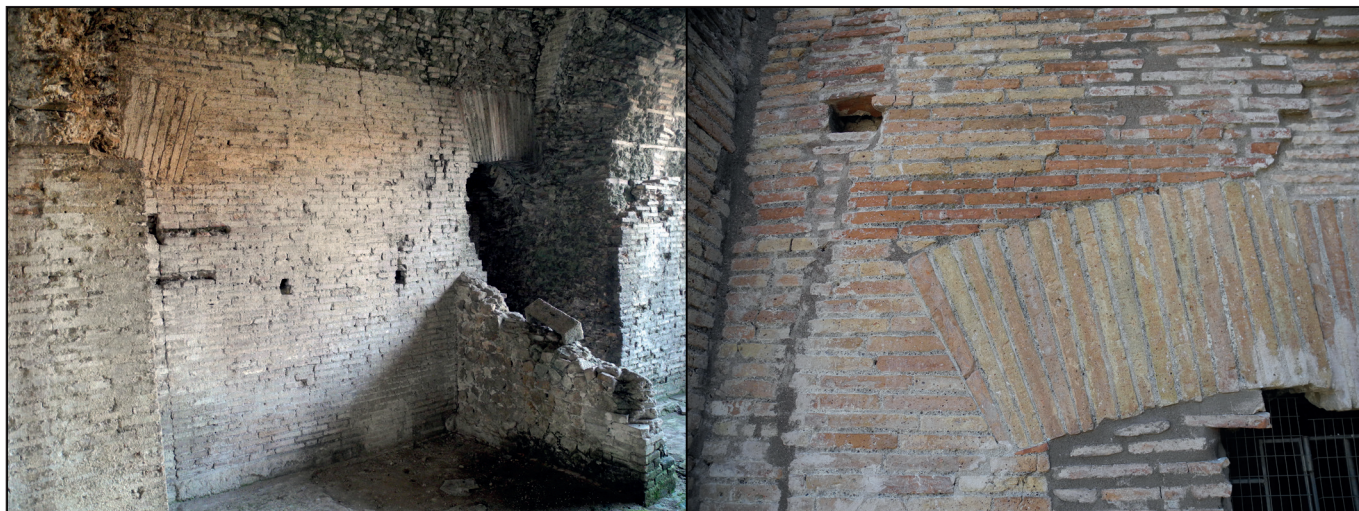
Fig. 5. Viste dell'edificio adrianeo. A sx, divisorio interno del primo piano con le due porte di passaggio (parzialmente tamponate da pilastri di epoca severiana) e tramezzo con paramento interno in opera incerta e stipite in laterizi. A dx, porta di ingresso del primo piano vista dal pianerottolo delle scale; sopra la ghiera della porta è visibile l'ammorsatura fra i laterizi giallo-arancioni della facciata e quelli di colore arancione scuro del divisorio.
