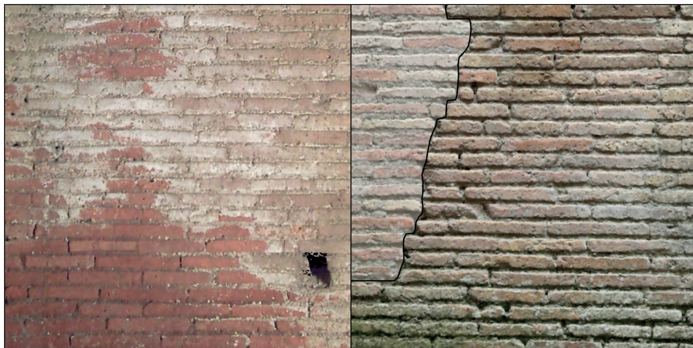
Fig. 9. Campioni di muratura (1 mq) del corpo scale, a sx, e della facciata, a dx (elaborazioni da rilievo con laser scanner). Nel campione della facciata, il contorno individua una porzione rifatta in epoca severiana.
