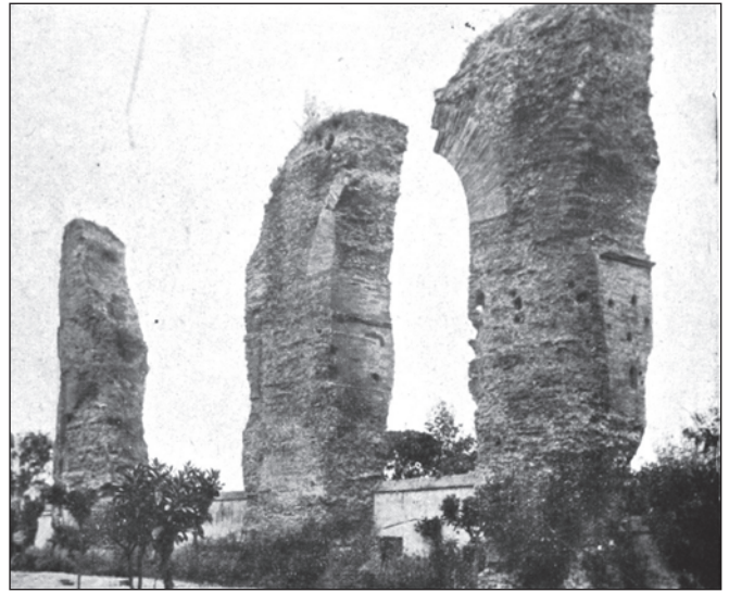
Fig. 15. Fase severiana del acueducto neroniano-celmontano en el huerto de los Padres Pasionista. (Imagen de: Colini, op. cit. nota 42)
