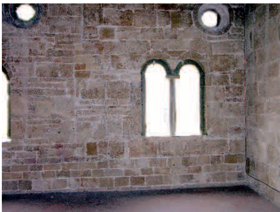
Figura 27. Paramento interior del pórtico de San Zeno (Pisa), en el que se advierten las dos fases constructivas (fase 3a, fase 3b)
