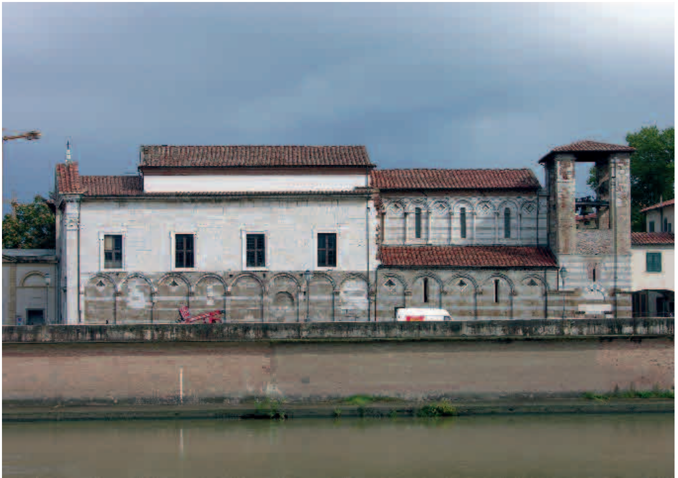
Figura 18. Vista general de la iglesia de San Matteo desde el sur, en la que se reconoce la reconstrucción del siglo XVII iniciada en la fachada y la fase medieval del siglo XII
