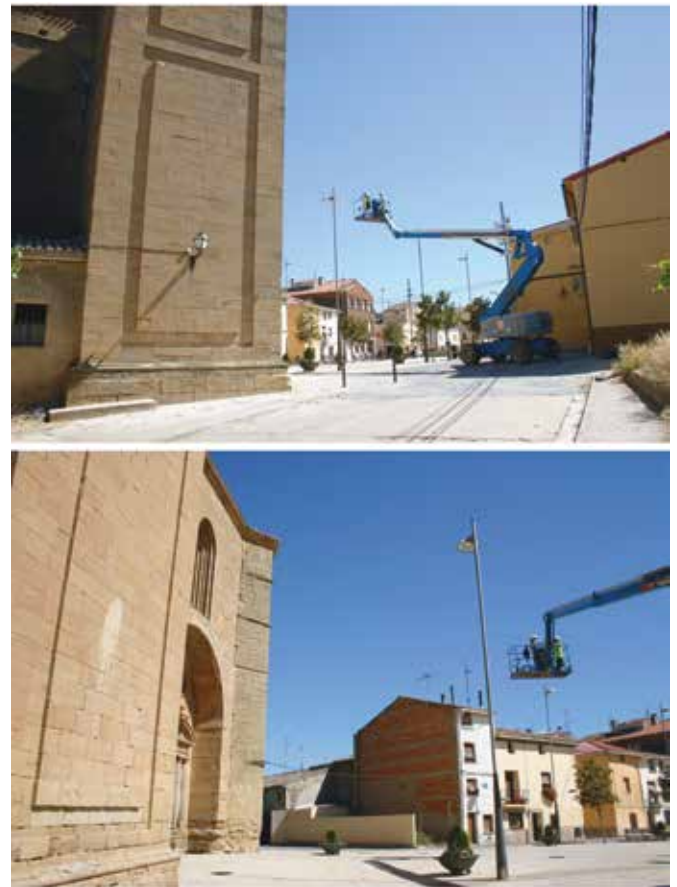
Figura 15.- Toma de los pares estereoscópicos de la fachada de la iglesia de Agoncillo con ayuda de una grúa autoportante.
