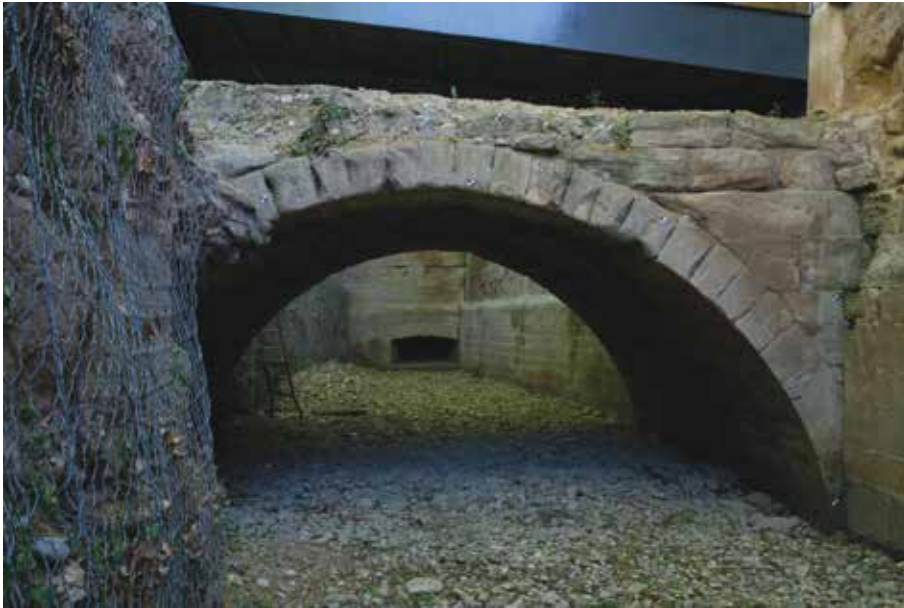
Figura 8.- Puente de acceso a la «Puerta del Camino» de la muralla de Logroño, en 2009 antes de su restauración.
