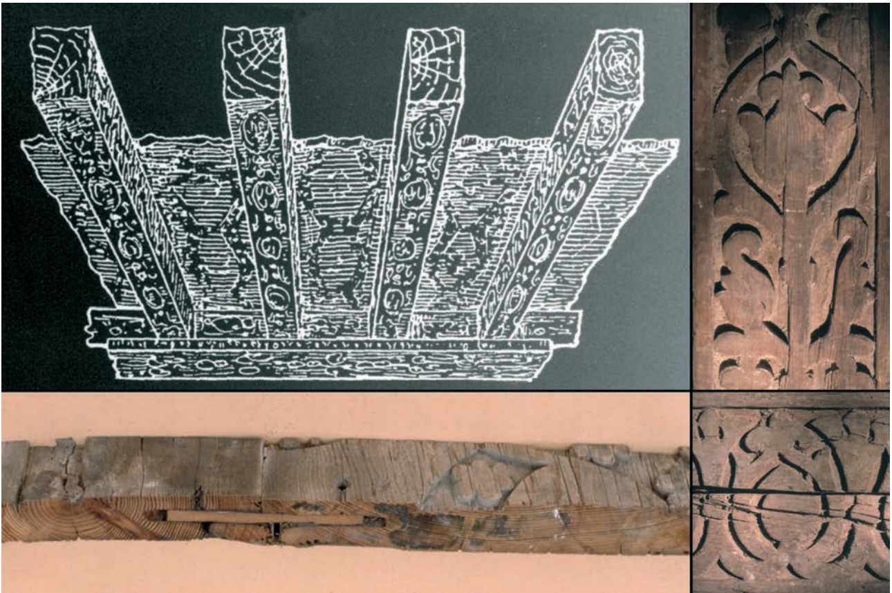
Fig. 6. Reconstrucción de Félix Hernández (1928) de la techumbre de la Aljama de Córdoba. Las vigas eran enterizas y las tablas se unían a media madera con espigas. La decoración de las vigas cubría tres caras, pero ha sido necesario recomponer su decoración lateral pues la mayoría se cortaron al ser reutilizadas en el siglo XVIII
