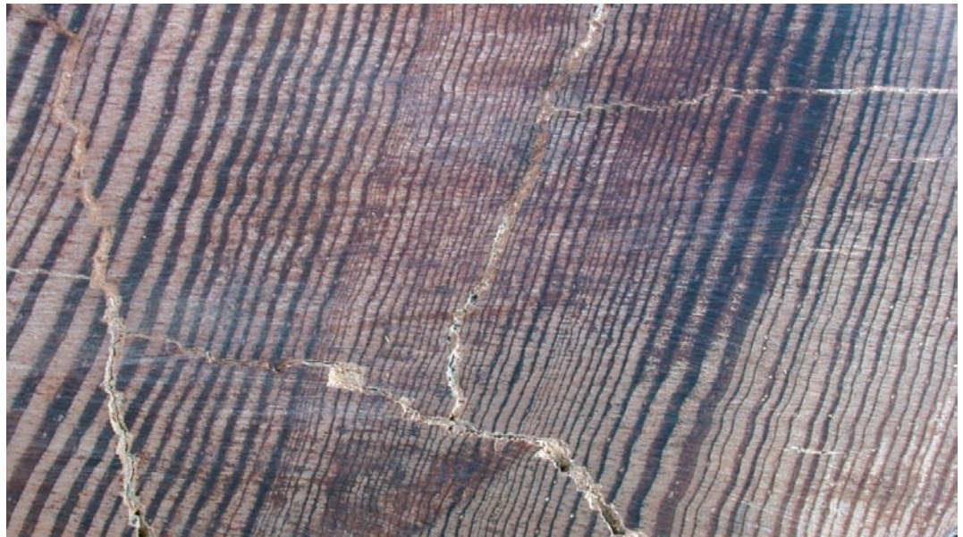
Fig. 9. Tirante de S. Juan de Baños. Madera de pino con fuertes fluctuaciones en su secuencia de anillos y alto contenido de resina que indican condiciones limitantes del crecimiento
