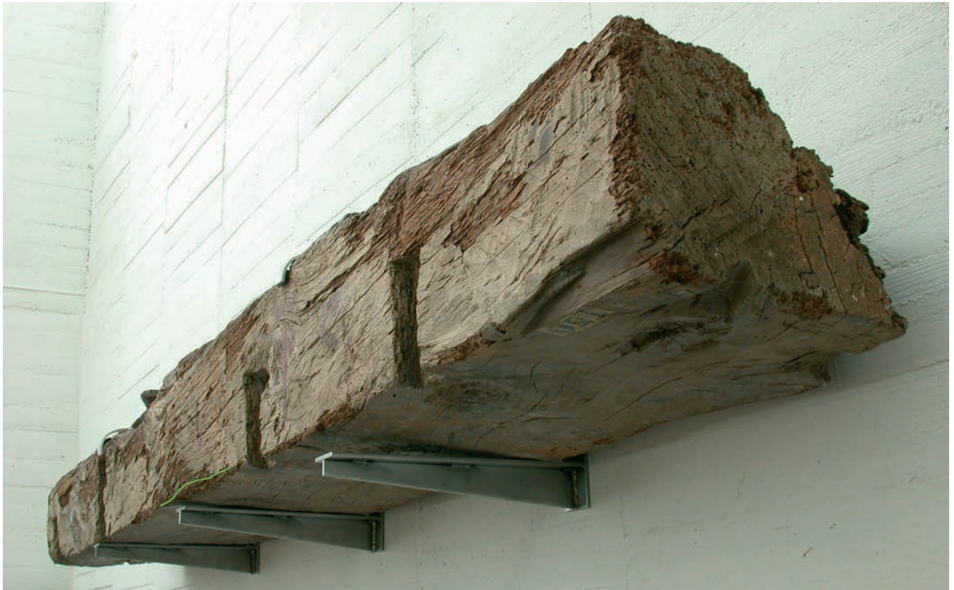
Fig. 15. Viga de S. Pedro de la Nave. El acabado de la cara superior fue muy tosco al igual que su cajeadado por utilizarse herramientas de cantero: escoda, trinchante y cortafrió (ALONSO LUENGO, cit. ALONSO et al. , 2004). Tal como señala la línea verde, la superficie se dejó algo abombada en la zona nudosa del centro de la cara, donde no asentaban los sillares por coincidir con la ventana suprabscial.
