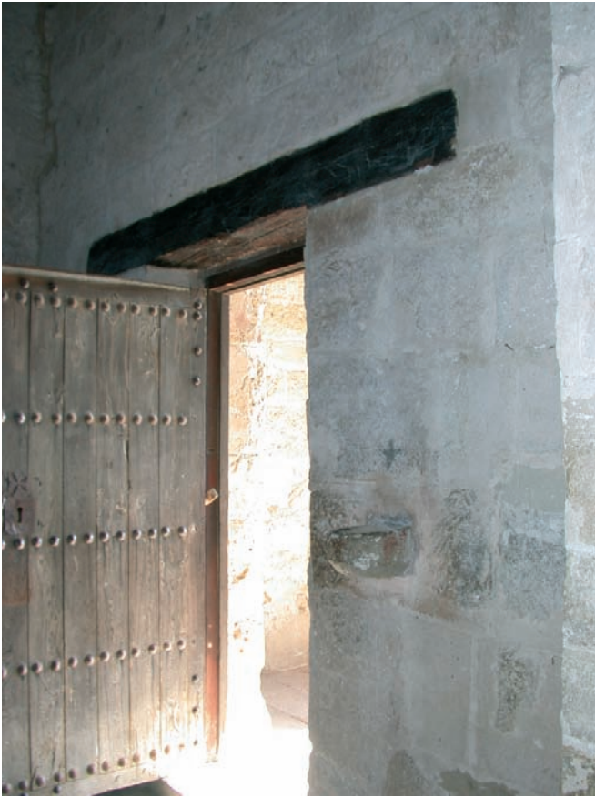
Fig. 13. Dinteles del acceso oeste de S. Juan de Baños. Labrados a hacha, presentan largos empotramientos en el muro que sobrepasan la luz del vano
