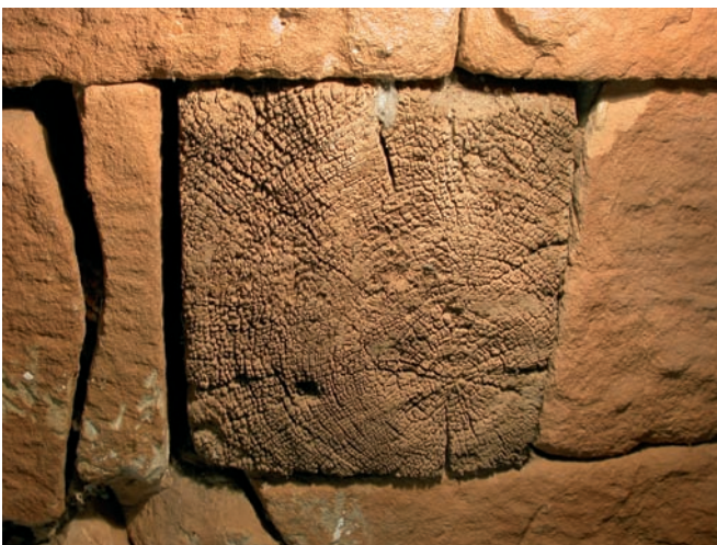
Fig. 14. Testa de la viga sur de Quintanilla de las Viñas: pieza enteriza que se labró con perfecto ajuste con los sillares. Muestra una degradación superficial que indica una acción prolongada del sol y la lluvia (surcos de 10 mm de calado), por lo que este paramento tuvo que estar durante mucho tiempo sometido a la intemperie
