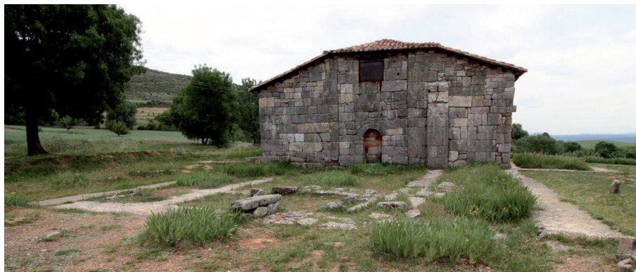
Figura 3.- Quintanilla. Vista general desde oeste.
