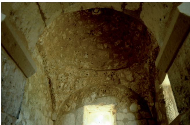
Figura 24.- Santa Cecilia de Tabladillo (Barriosuso, prov. Burgos). Bóveda baída del ábside.
